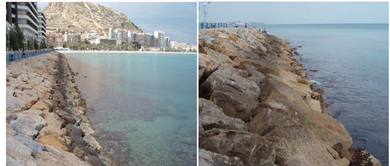
Figura 73 Tanto en la escollera junto a la playa del Postiguët (izq.) como a la del dique del puerto (dcha.), domina ampliamente el alga Corallina elongata .
