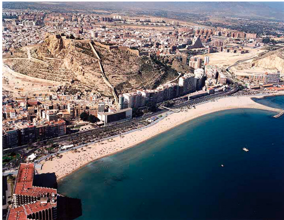
Figura 119 Vista aérea de la playa del Postiguet, el paseo en su trasdós, el núcleo urbano, el Benacantil, el Castillo de Santa Bárbara, el tómbolo y el dique exento, y el inicio del tramo escollerado frente a la estación FGV.
