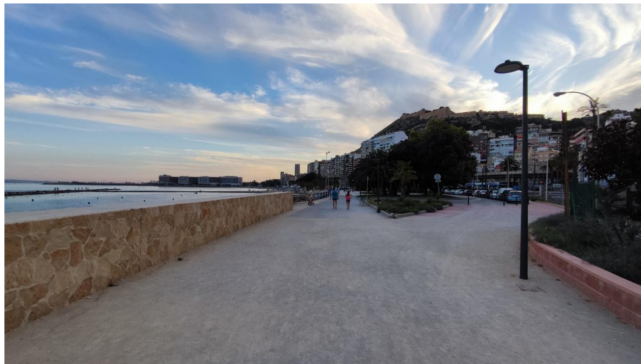
Ilustración 4. Tramo final adoquinado hasta el colector de pluviales y arranque del nuevo espigón.
