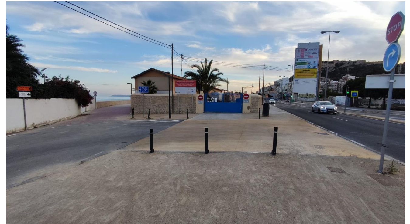
Ilustración 1. Acceso a la obra para vehículos por Avenida de Villajoyosa.
