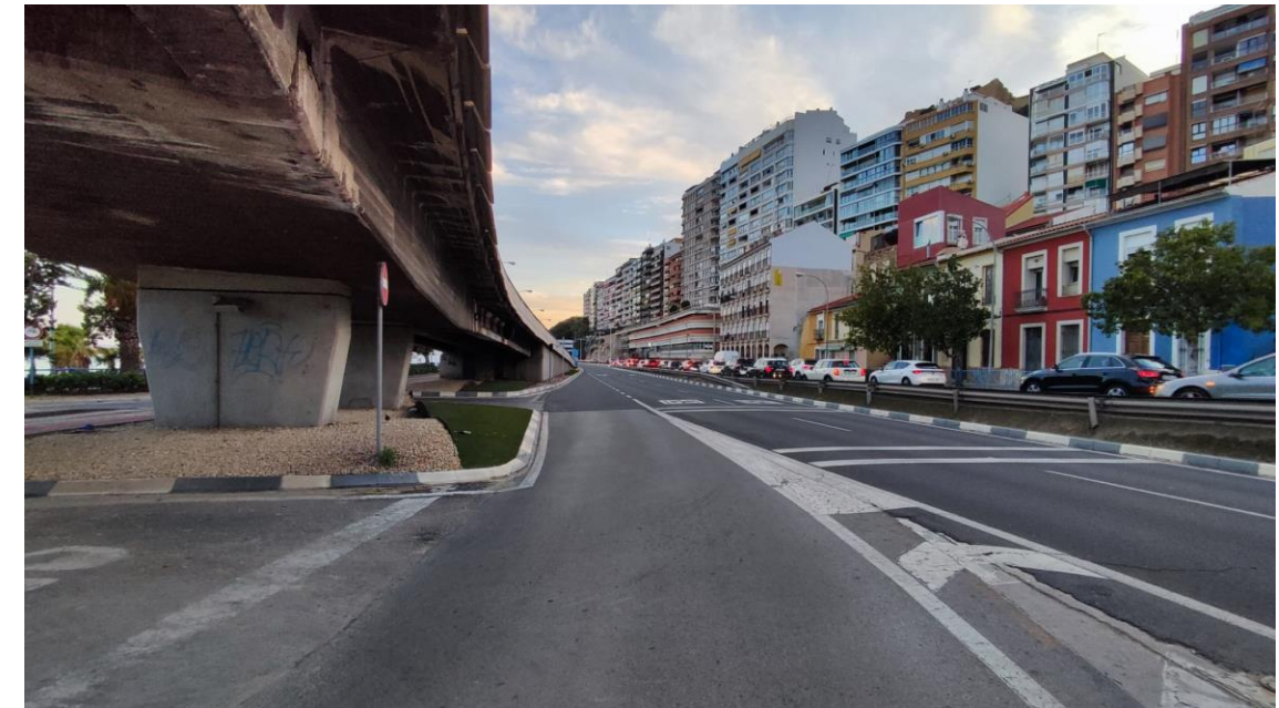
Ilustración 5. Vial de acceso a la entrada de la obra bajo el paso elevado de la N-332. Gálibo insuficiente bajo el paso superior en la entrada actual, entrada a inhabilitar durante las obras
