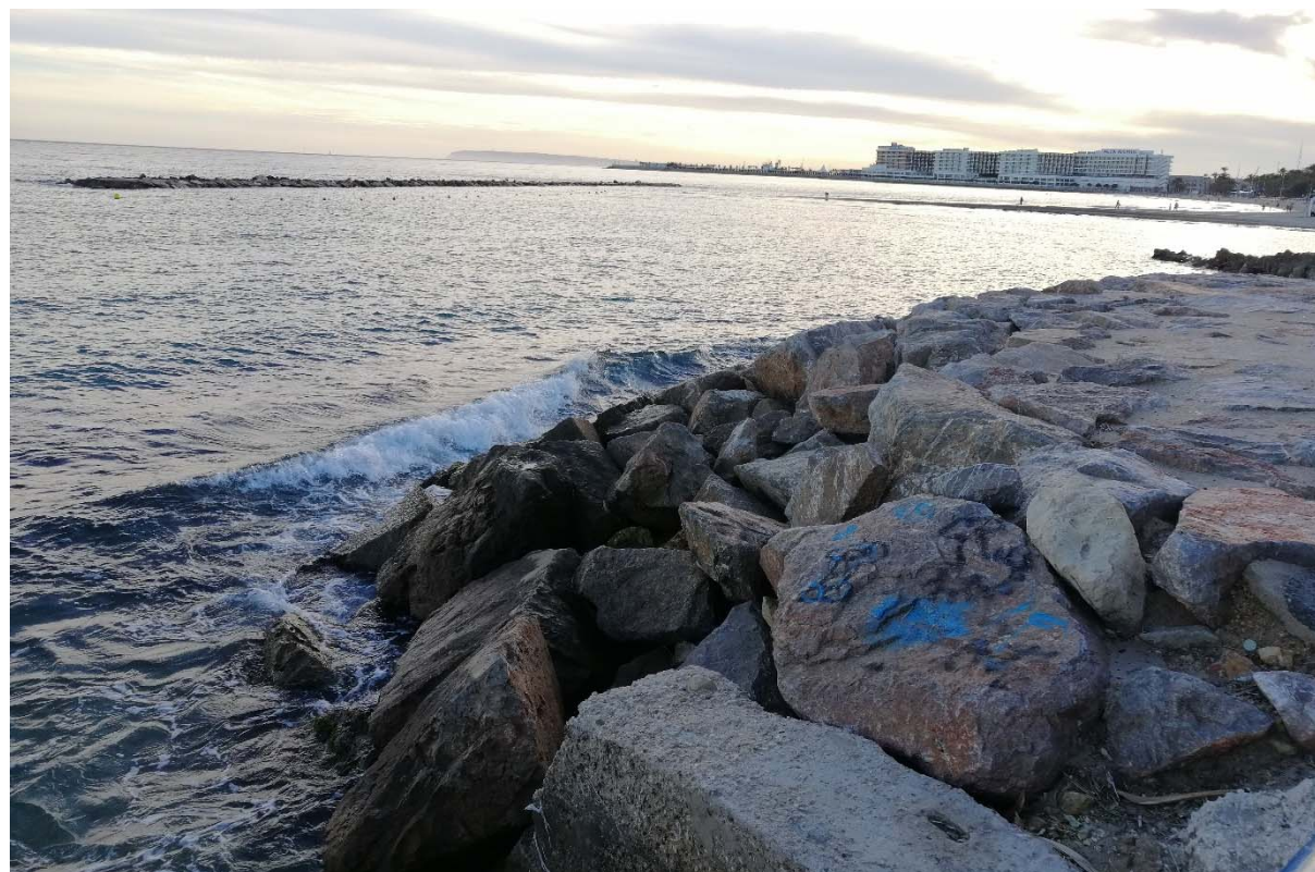
Figura 10 Tramo escollera existente entre el desagüe de pluviales y la playa del Cocó. Vista al fondo del hemitómbolo y el dique exento, y más allá, del dique de Levante del Puerto de Alicante donde se ubica el Hotel Meliá.
