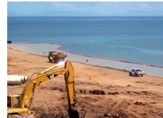
Figura 1 Ejemplo de cortina antiturbidez aplicada en regeneración de playas
