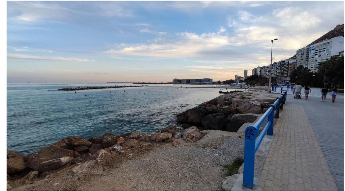
Ilustración 9. Paseo de Gómiz peatonal a vallar durante la ejecución de la obra, junto el arranque del nuevo espigón. Reparación posterior en caso de producirse daños debido al paso de la maquinaria pesada.
