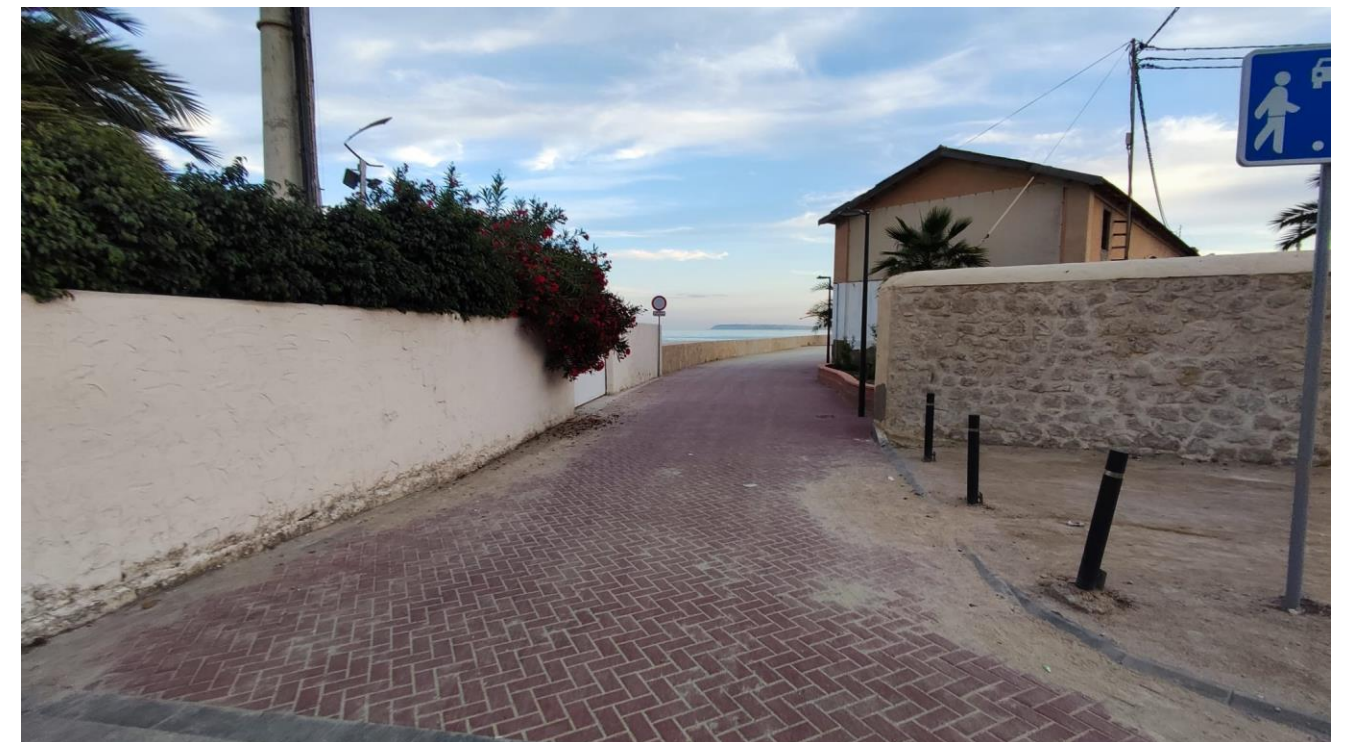
Ilustración 2. Pavimento adoquinado de acceso a la obra por el Paseo de Gómiz.
