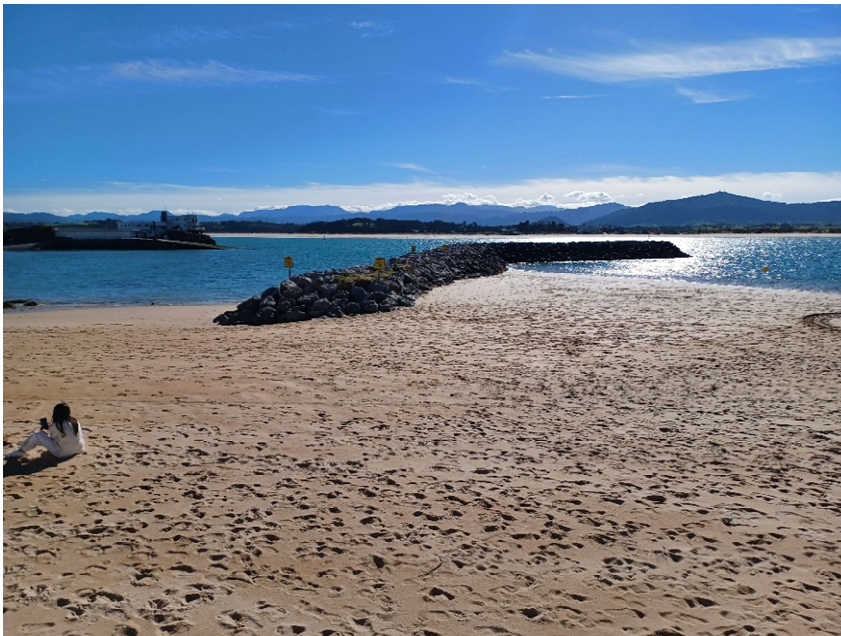
Imagen 2. Vista general del espigón balizado.
