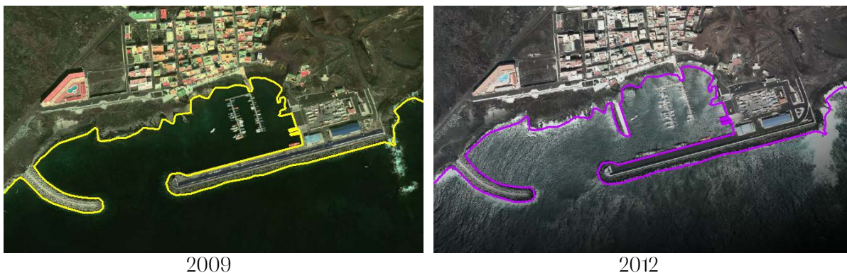
Figura 99. Ampliación del puerto de la Restinga.
