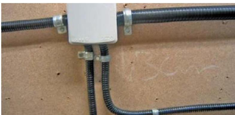
**Ilustración 44:** Tubos flexibles no metálicos
