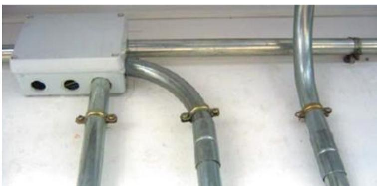
**Ilustración 41:** Tubos rígidos metálicos
