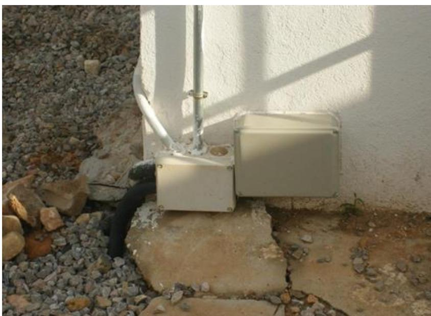
**Ilustración 46:** Canalización enterrada
