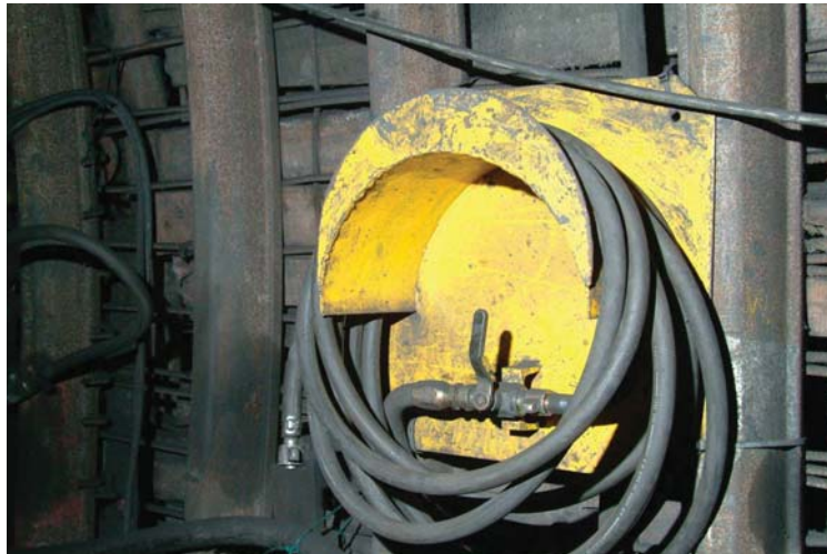
Figura 74. Manguera de agua dentro de la obra subterránea
