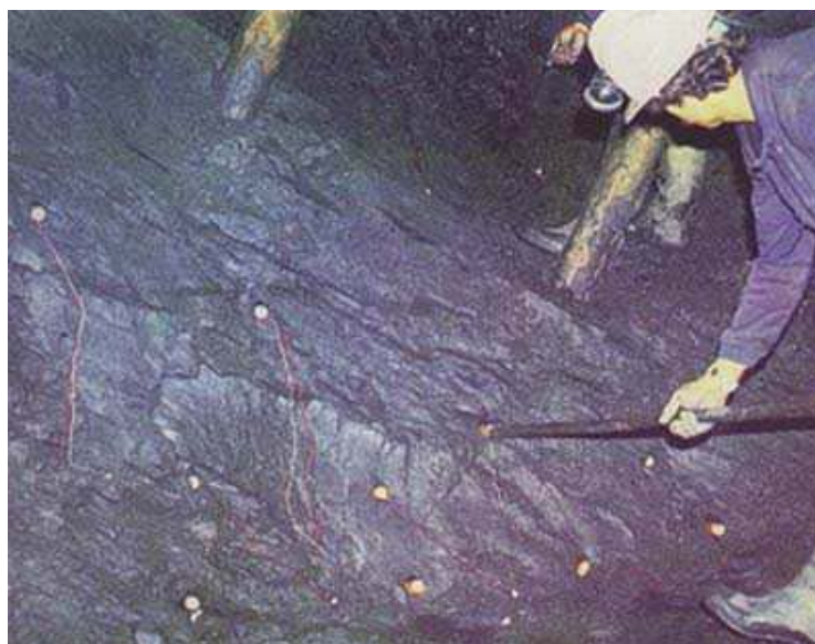
Figura 49. Retacado de cartuchos para voladura en arranque de carbón.
