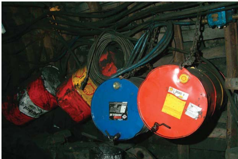
Figura 18. Almacenamiento de cables y aceite
