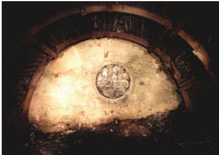
Figura XXVIII. Tabique doble definitivo con cámara intermedia y revestimiento de hormigón exteriormente en toda la sección de galería con guillotina para paso de personal.
