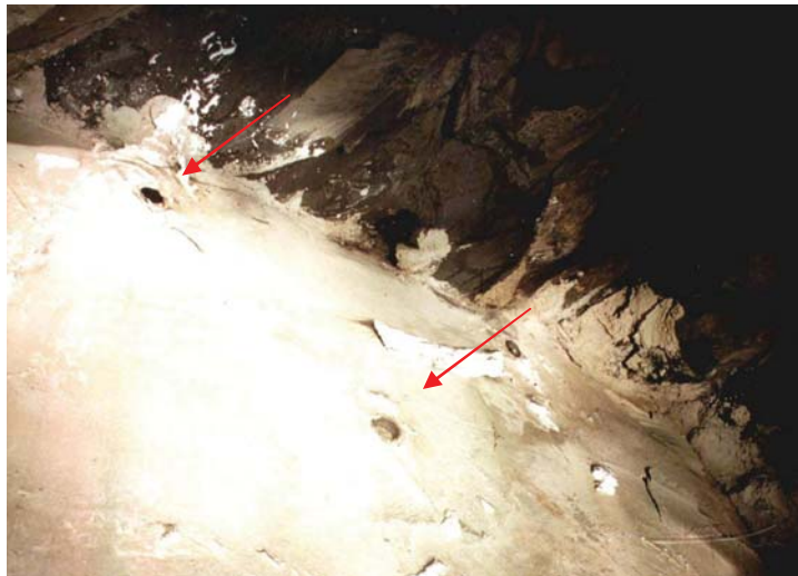
Figura XXVII. Tubos para inyección de espuma a la cámara intermedia para conseguir total estanqueada.
