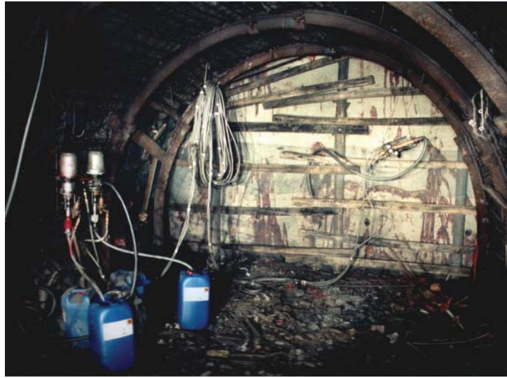
Figura XIX. Primera etapa de construcción de un pre-tabique: enmaderado
