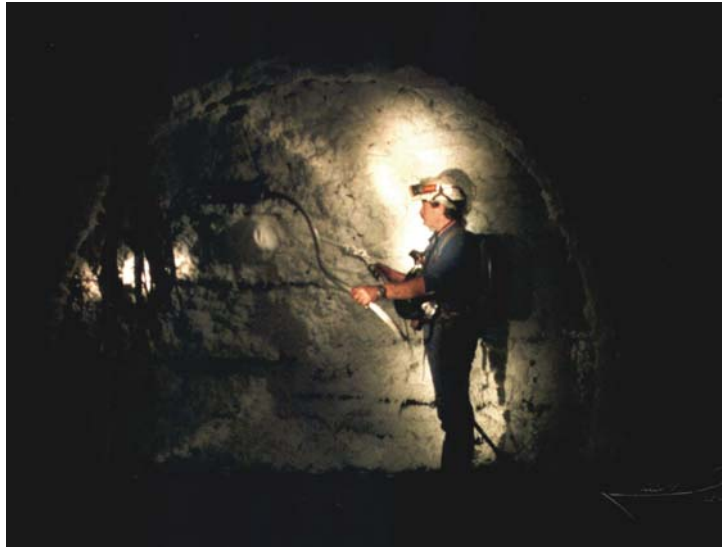
Figura XXI. Últimos detalles en la construcción de un pre-tabique
