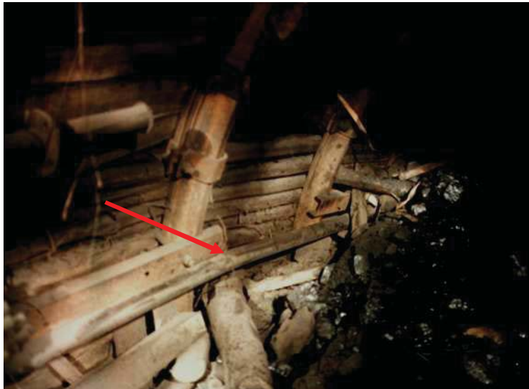
Figura 83. Tubería de Inyección de nitrógeno en el frente
