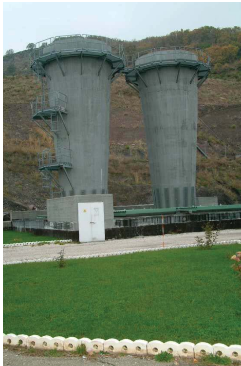
Figura 8. Torres de ventilación de una mina
