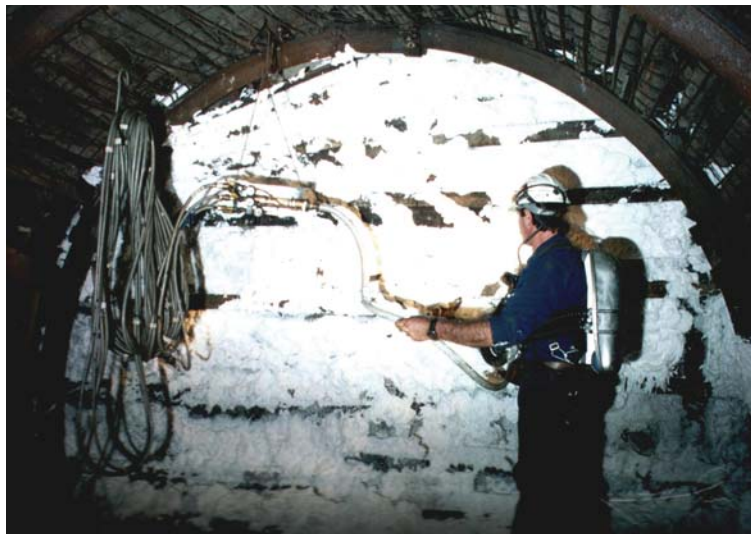
Figura XX. Segunda etapa de construcción de un pre-tabique: aplicación de resinas
