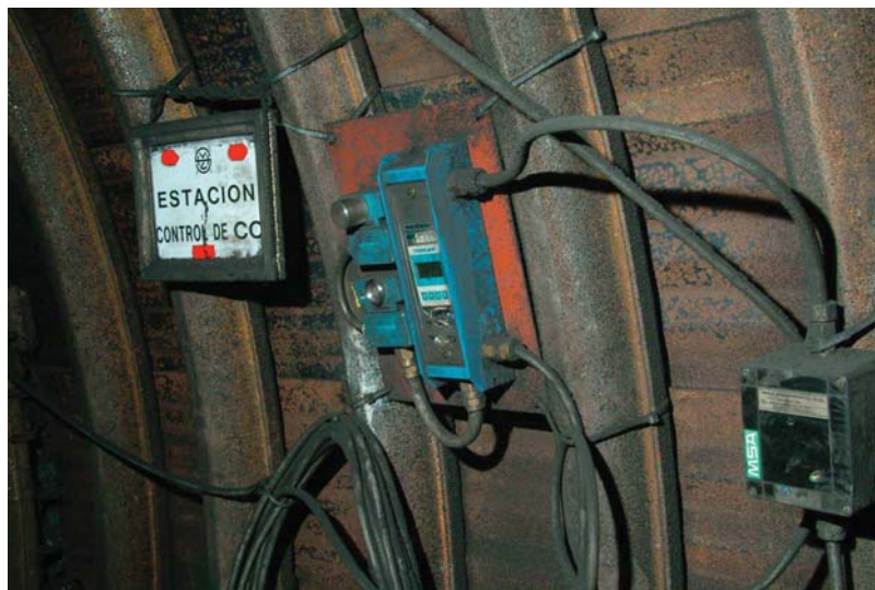
Figura 52. Estación fija de detección de CO cerca de cabeza motriz de cinta transportadora
