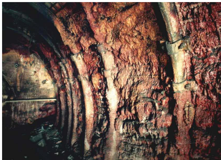
Figura 35. Revestimiento con resinas para la eliminación de fugas
