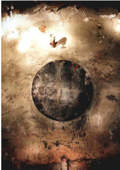
Figura XXV. Tubos de 2" con la llave de compuerta para tomar muestras en el interior del tabique. En el tubo superior se toman muestras de \text{CH}_4 , \text{CO} , \text{O}_2 ) y cierre de guillotina de 800mm de diámetro.
