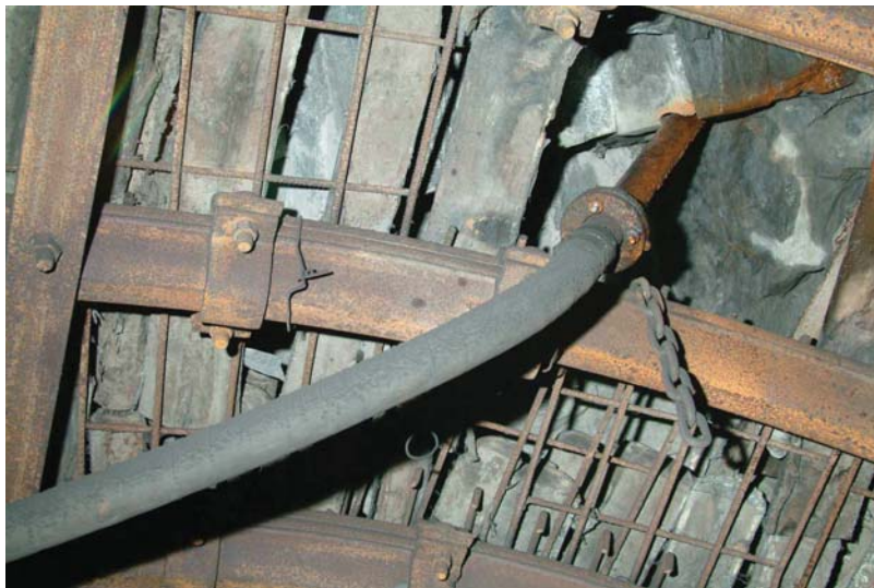
Figura 75. Sondeo entubado para inyección de agua en taller
