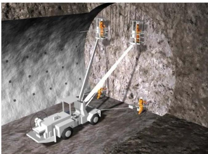
Figura 5.3: carga del explosivo en el frente
