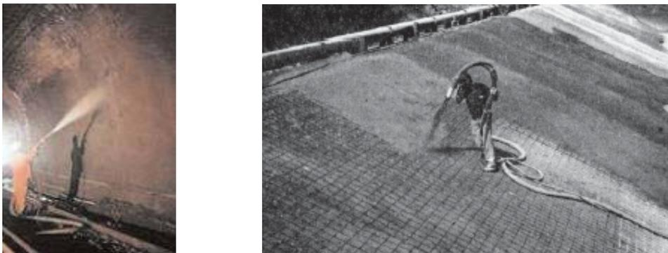
Figura 7.7: Procedimientos de aplicación de hormigón proyectado
