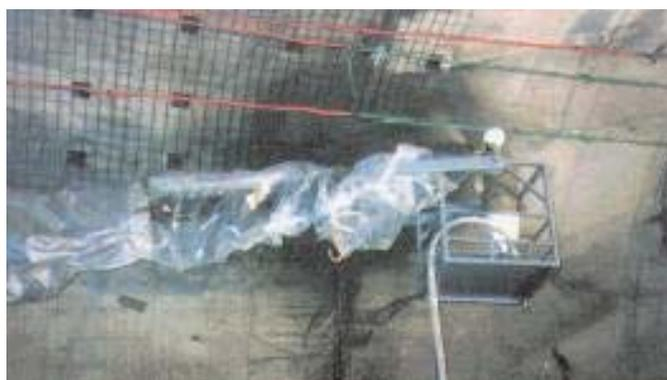
Figura 7.10: Colocación de malla
