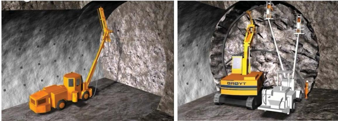
Figura 7.3: Sostenimiento mediante bulones y cerchas
