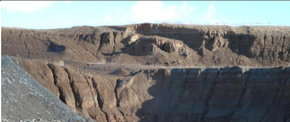
*Detalle de rotura progresiva (banco superior) y formas de erosión en el banco inferior*
