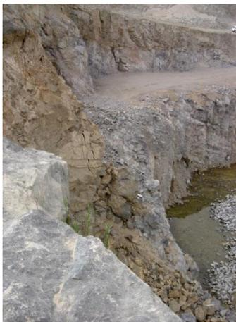
*Detalle de rotura plana y vuelco de bloques*
