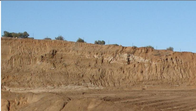
*Huellas de trabajo (ripado) sobre la cara del talud*
