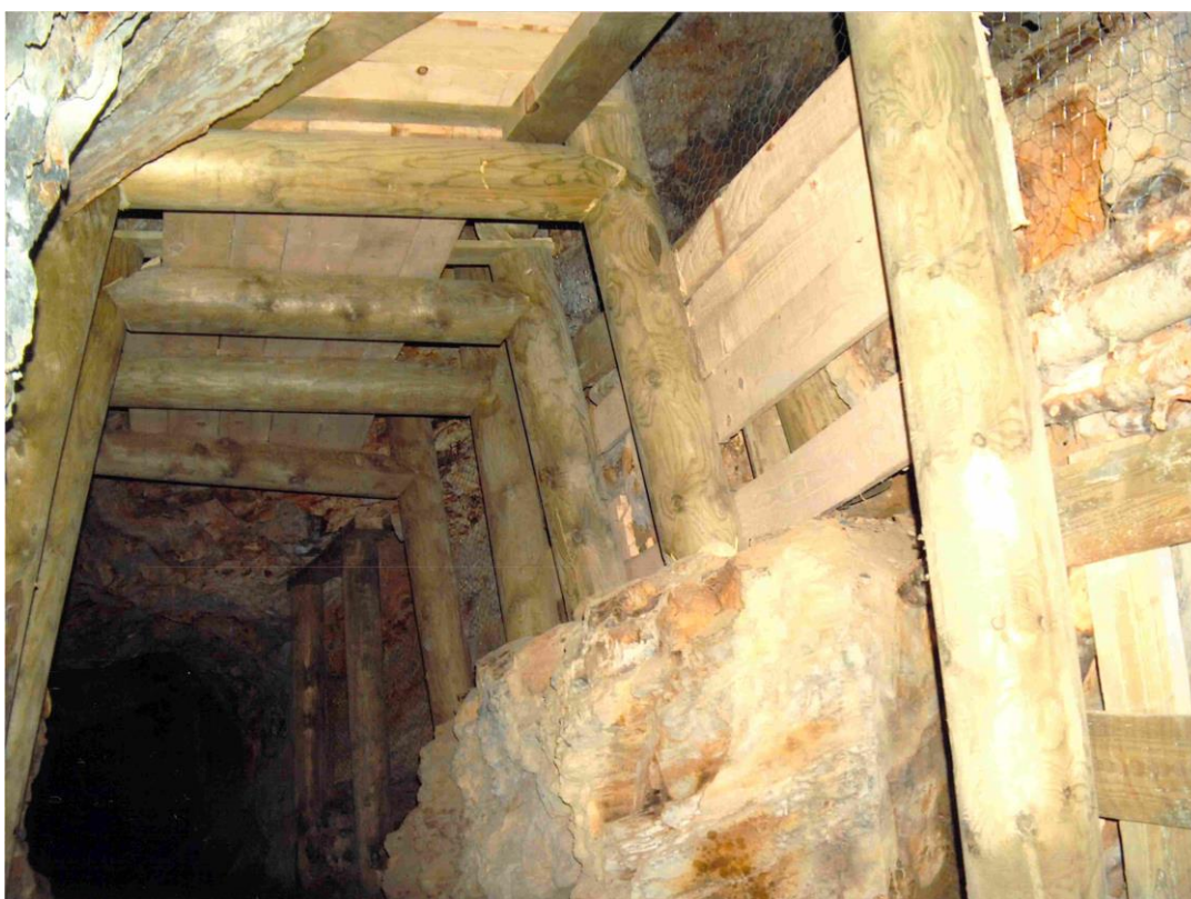
Figura 7- Recuperación de galería "Mina Solita" (Inproobras, S.L.)
