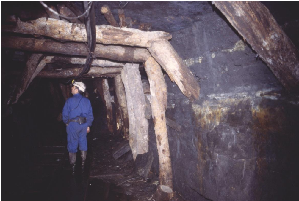
Figura 1- Sostenimiento de galería con cuadros de madera. Mina Solita de Bemibre (Foto: L.Jordá).
