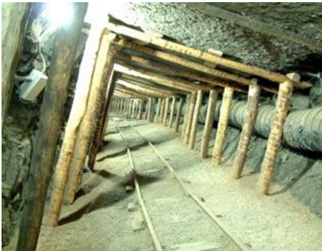
Figura 2- Sostenimiento de galería buzamiento estratos < 40°. (Museo Minero Escucha)
