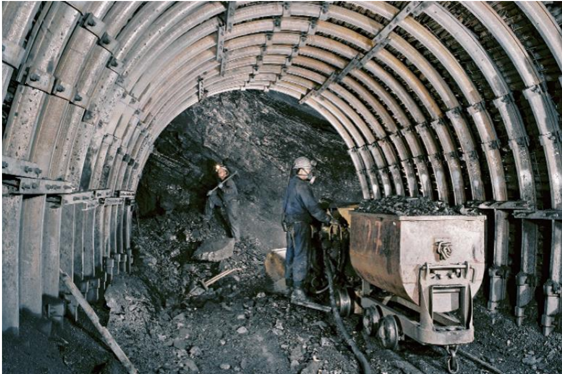
Figura 4 - Avance de galería subterránea (UMINSA).
