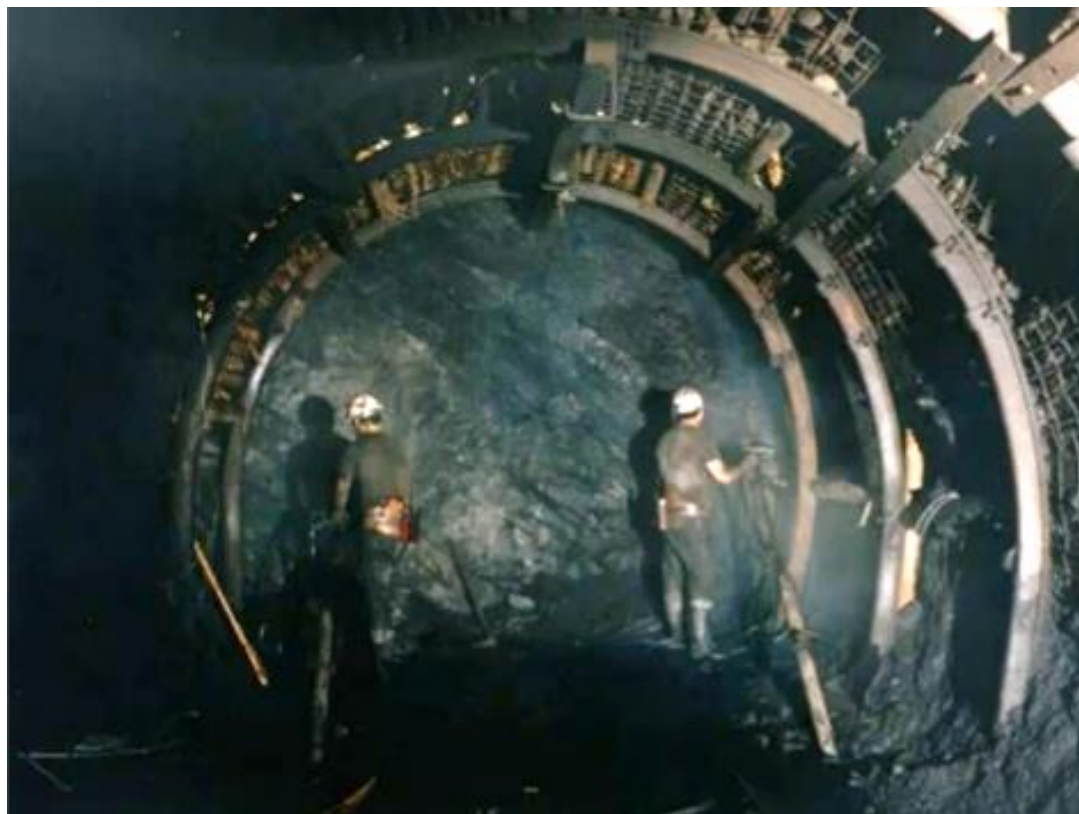
Figura 46 - Guarnecido con parrilla metálica y madera, (MSP).
