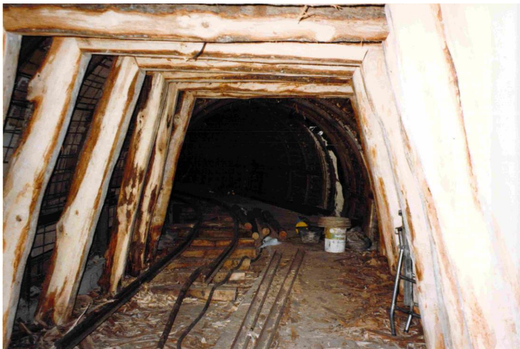
Figura 3- Sostenimiento de galería con madera "Mina visitable Barruelo de Santullán" (Inproobras, S.L.)
