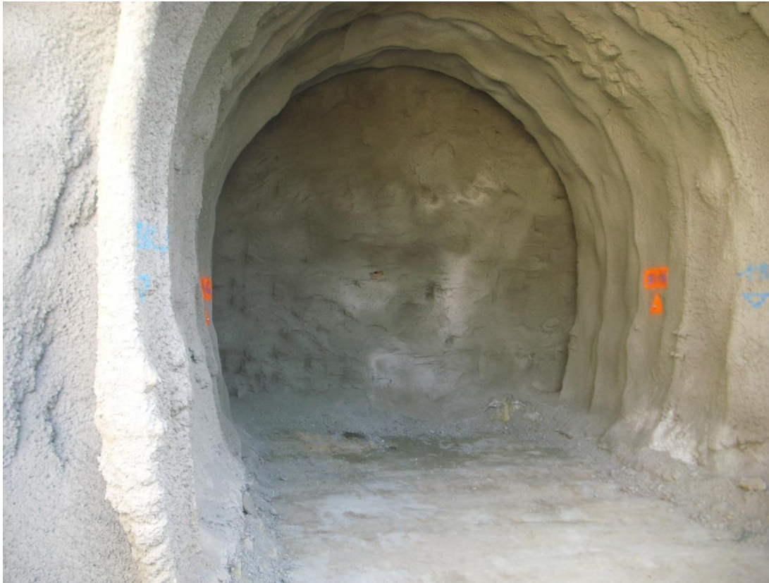
Figura 65 - Sostenimiento con cuadros y gunita (Inprobras S.L.).
