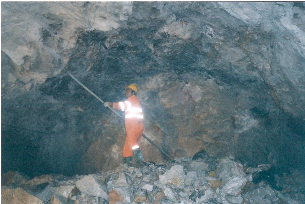
Figura 35 - Trabajos de saneo manual (Inproobras S.L.)
