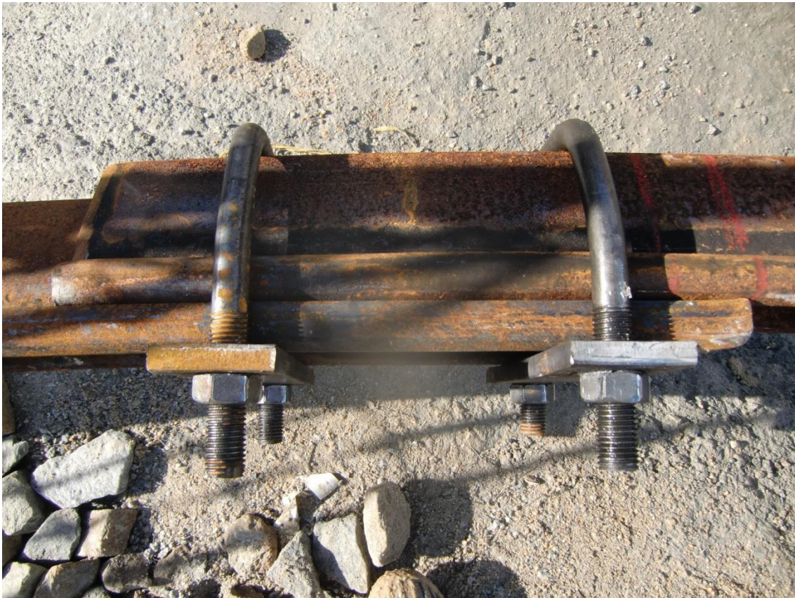
Figura 41 - Unión tipo abarcón (Foto: A. Berrocal)
