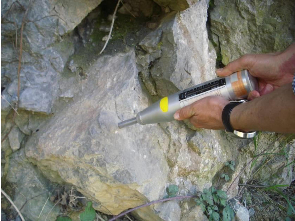
Figura 5- Ensayo con martillo SCHMIDT (Inproobras S.L.).
