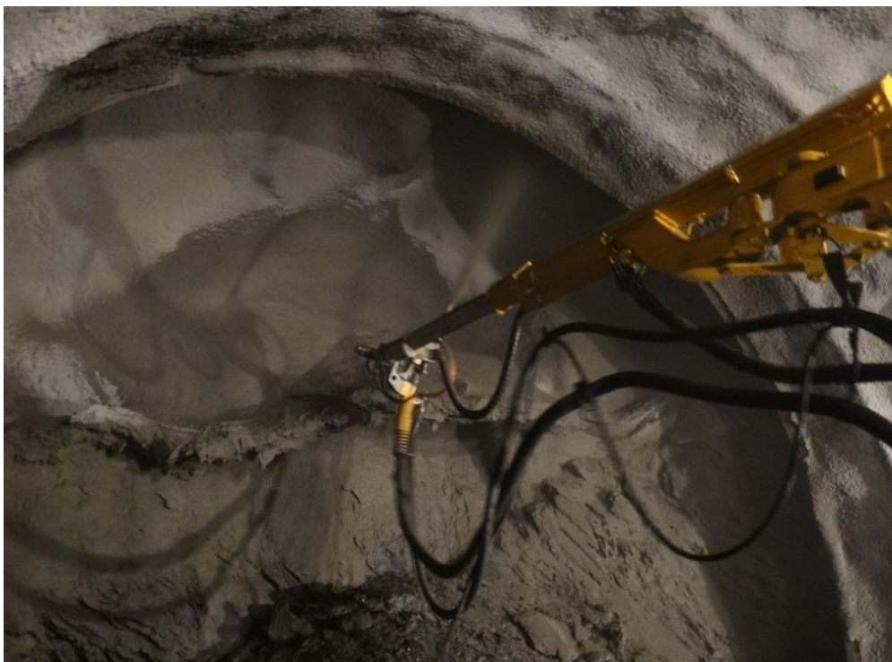
Figura 68 - Proyección de gunita con robot en galería (Foto: A.Berrocal).
