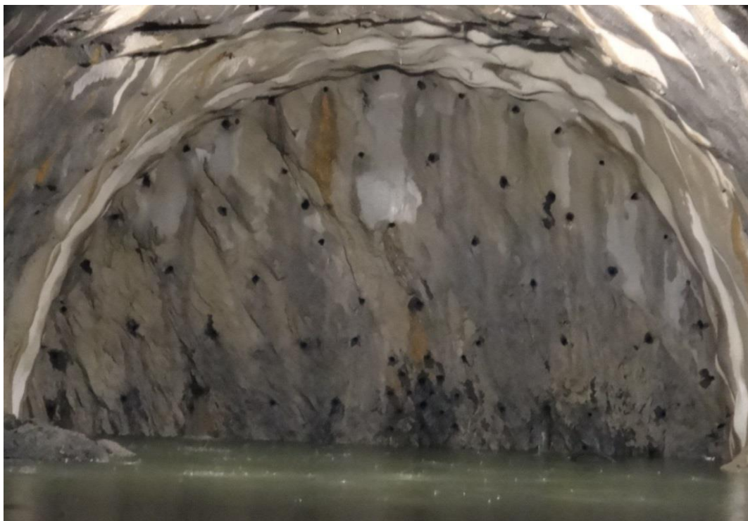
Figura 21 - Pega perforada para voladura en galería. El uso de voladuras puede afectar a zonas ya sostenidas y debilitarlas. (Foto: A.Berrocal).
