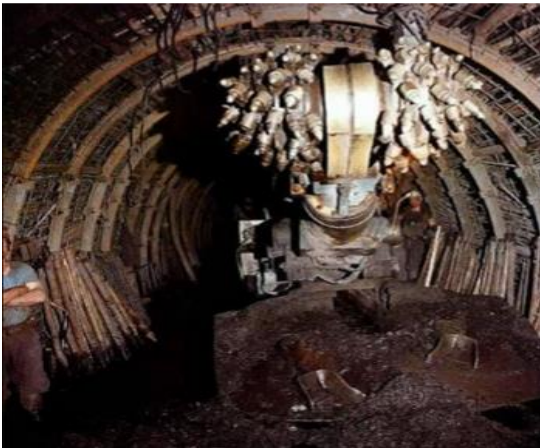
Figura 20 - Excavación mediante minador (Inproobras S.L.).
