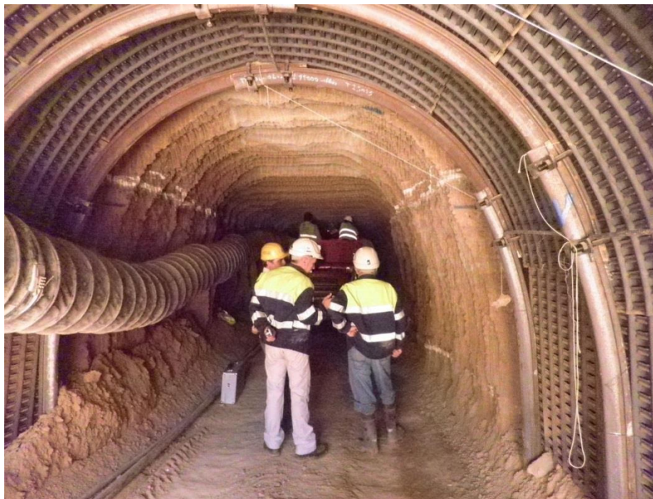
Figura 43 - Guarnecido con chapa tipo bernold (Inproobras S.L.).
