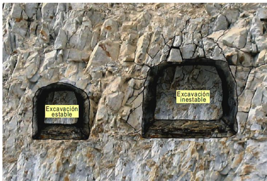
Figura 104 - Influencia de las dimensiones de la excavación sobre la inestabilidad. Incremento del riesgo al aumentar la sección. (S.N.M.P.E, 2004).
