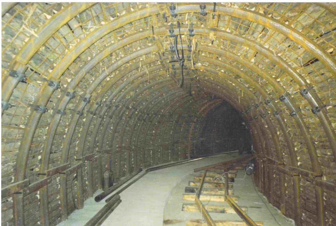
Figura 37 - Cuadros metálicos sobre cuadros de madera (Inproobras S.L.)
