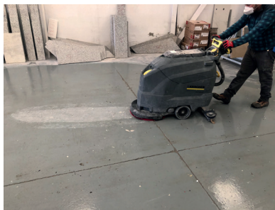
Fig. 6.3. Fregadora de suelos en marmolería (Fuente: INS)
