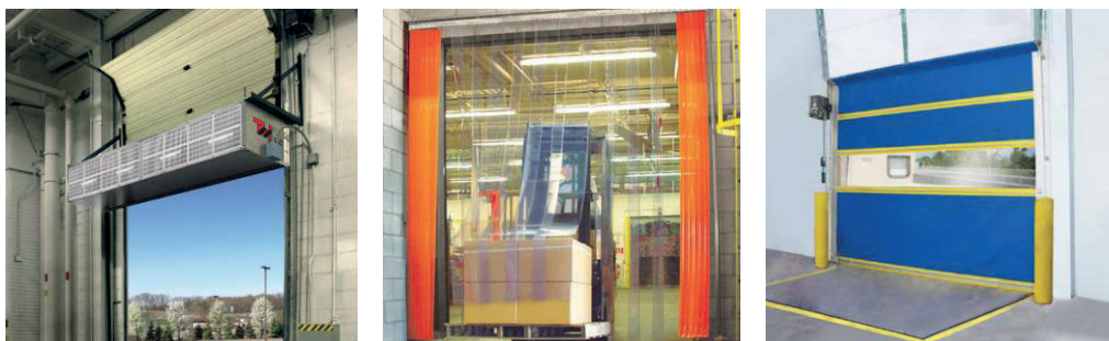
Fig. 5.10. Ejemplos de dispositivos para el control de la entrada de aire exterior (Fuente: TMI AIR BARRIERS. CHASE DOORS)
