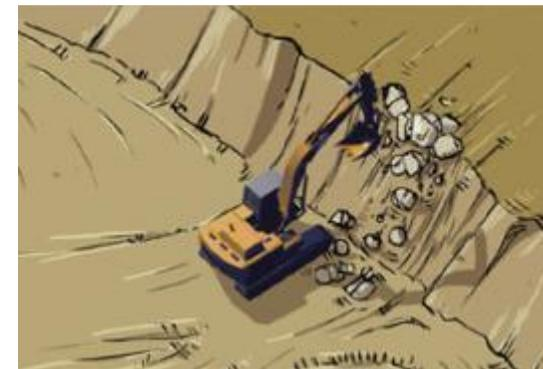
junto a la base del talud, posición en la que se incrementa el riesgo de impacto. Para que el trabajo se realice con la máxima seguridad, conviene cumplir las siguientes condiciones:
