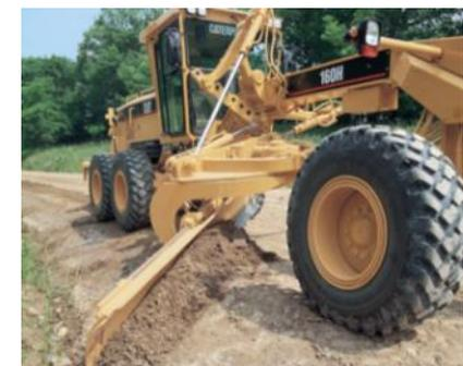
firme de las pista de transporte. Para su realización se utilizan los Tractores, sean de Ruedas o de Cadenas, las Motoniveladoras y las Palas Cargadoras.
