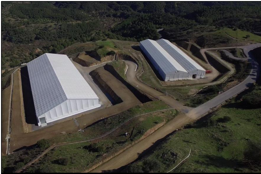
Figura 12. Instalación complementaria para el almacenamiento de RBBA
