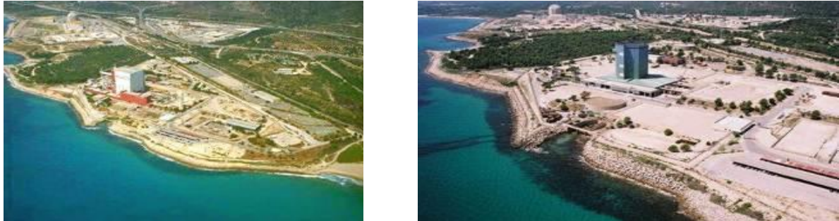
Figura 20. Aspecto del emplazamiento de la CN Vandellós I antes y después del desmantelamiento parcial
