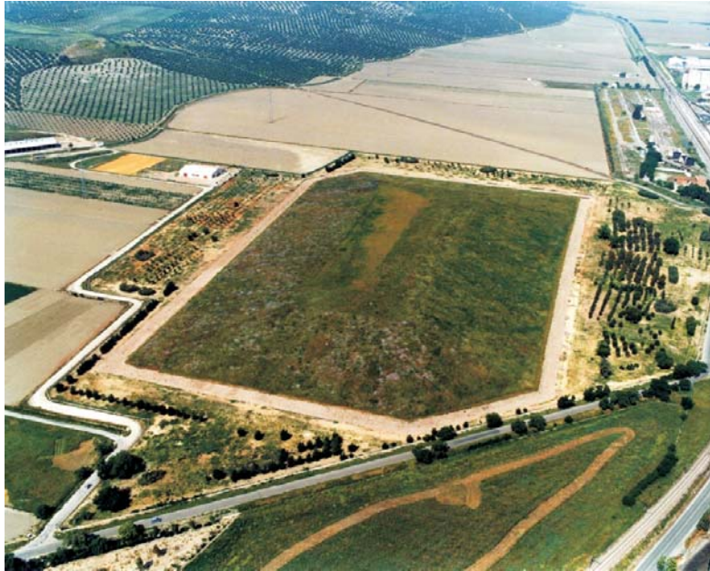
Instalaciones clausuradas: vista aérea del emplazamiento de la FUA.
