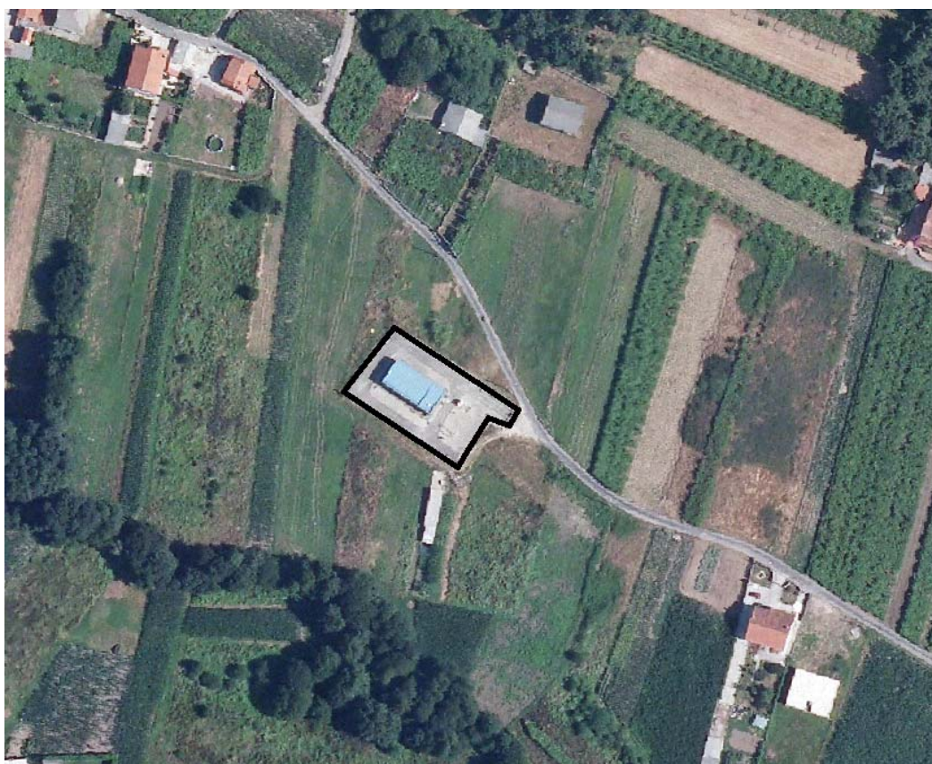
Figura 1: Estación de Regulación y Medida
