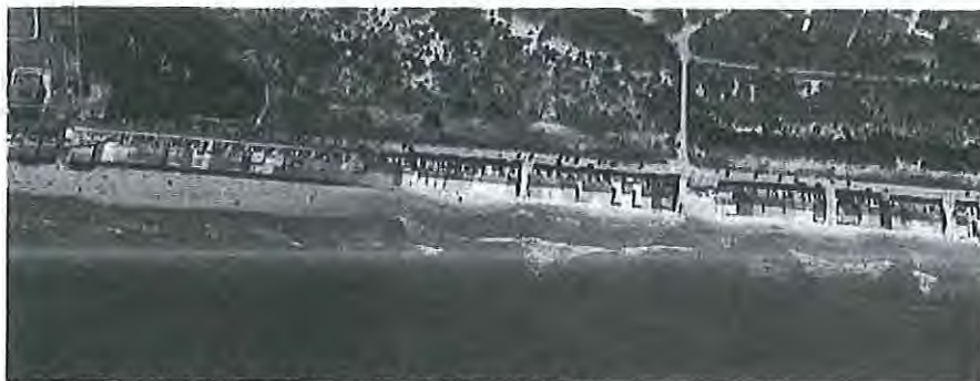
Ilustración 2: Vista de detalle de algunas de las viviendas afectadas.
