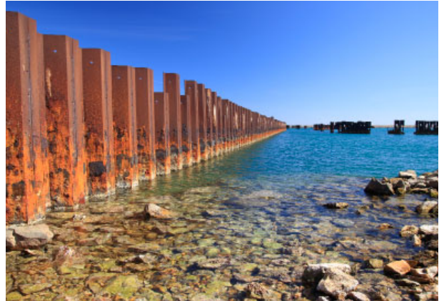
Estructura e instalaciones situadas en Puerto Mayor, en La Manga, que van a ser retirados y se procederá a la restauración ambiental de la zona.
