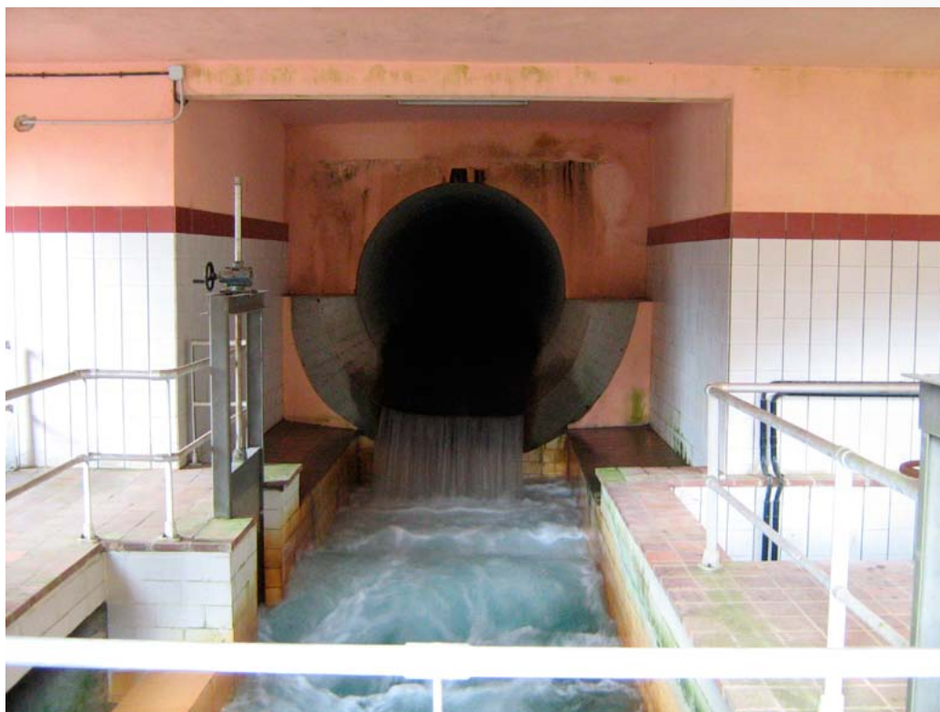
ILUSTRACIÓN 59 SALIDA DEL TÚNEL DEL ÁRAMO-ABASTECIMIENTO A OVIENDO
