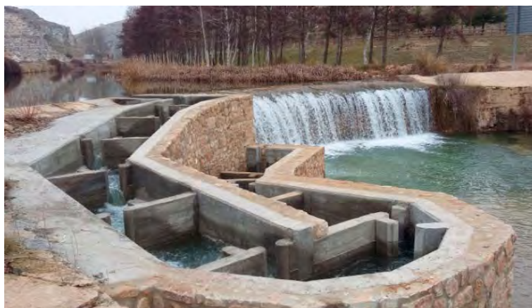
Escala para peces en azud de la Güera, sobre el río Ucero. Uno de los objetivos del proyecto es la recuperación de la continuidad longitudinal del sistema fluvial.
