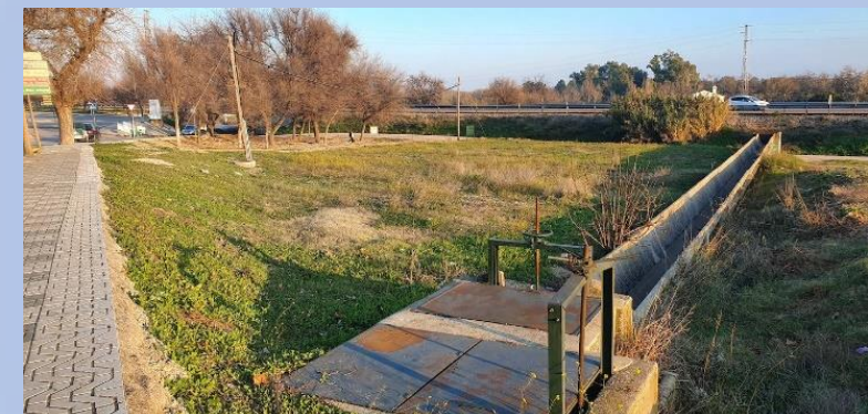
• MODERNIZACIÓN DE REGADÍOS DE LA Z.R. DEL RUMBLAR (JAÉN)
