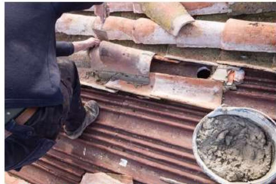
Fig. 16, 17 y 18. Apertura de orificios sobre onduline y madera, e instalación de la teja especial de acceso al
