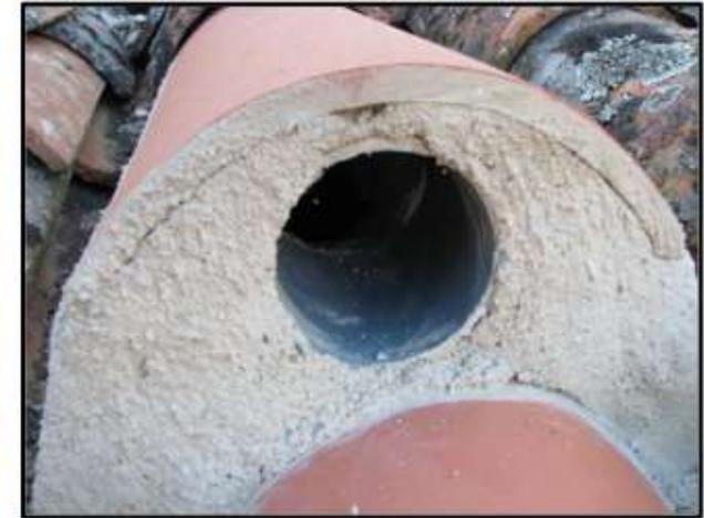
Fotos. Ejemplos de tejas de acceso mal resueltas en obras visitadas por técnicos de la DGS antes del proyecto LIFE
