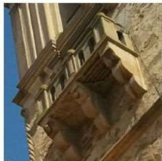
SE HA PRODUCIDO PERDIDA DE REVESTIMIENTO EN LA BASE DEL BALCÓN DEJANDO SIN PROTECCIÓN LAS ARMADURAS DEL VUELO FAVORECIENDO SU CORROSIÓN.
