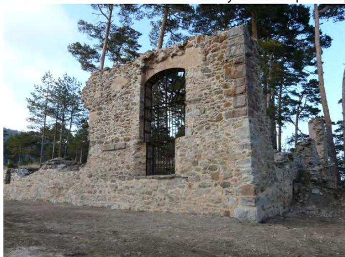
Los arranques del edificio son de piedra de sillería demostrando haber tenido bóveda debajo y según la elevación de los paredones, tres pisos. Su forma es cuadrada y la fachada principal mira al mediodía.
