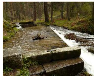
Está formado por 26 piezas de granito de 69 cm de anchura y longitudes variables, grapadas con llantones de hierro y recibidos con plomo. Está inclinado unos 45 grados con respecto al eje del río para derivar sus aguas por la margen derecha hacia un canal descubierto que vierte las aguas a un decantador de arenas que a su vez introduce el agua por la tubería enterrada.
