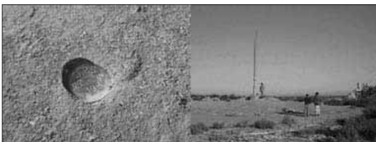
Figura 4. Placa de bronce con las iniciales J. P. S.-N. T. 106, empotrado en el basamento de una antigua baliza del río Guadalquivir, próxima a la casa de la salina de San Isidoro, tiene de cota 4,018 m respecto del nivel del mar en Alicante y se utilizó como punto de partida para dotar de altimetría a toda la marisma.
