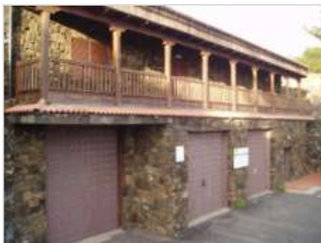
Puesto de Lucha contra Incendios
