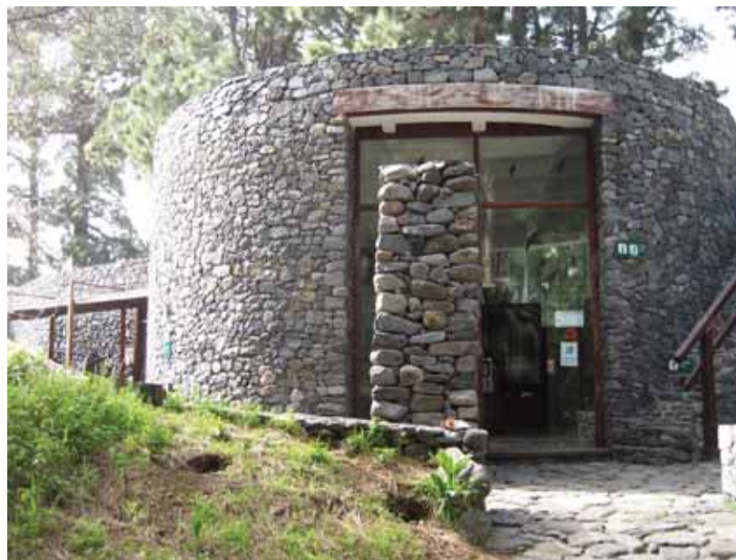
Centro de Servicios de Taburiente.
