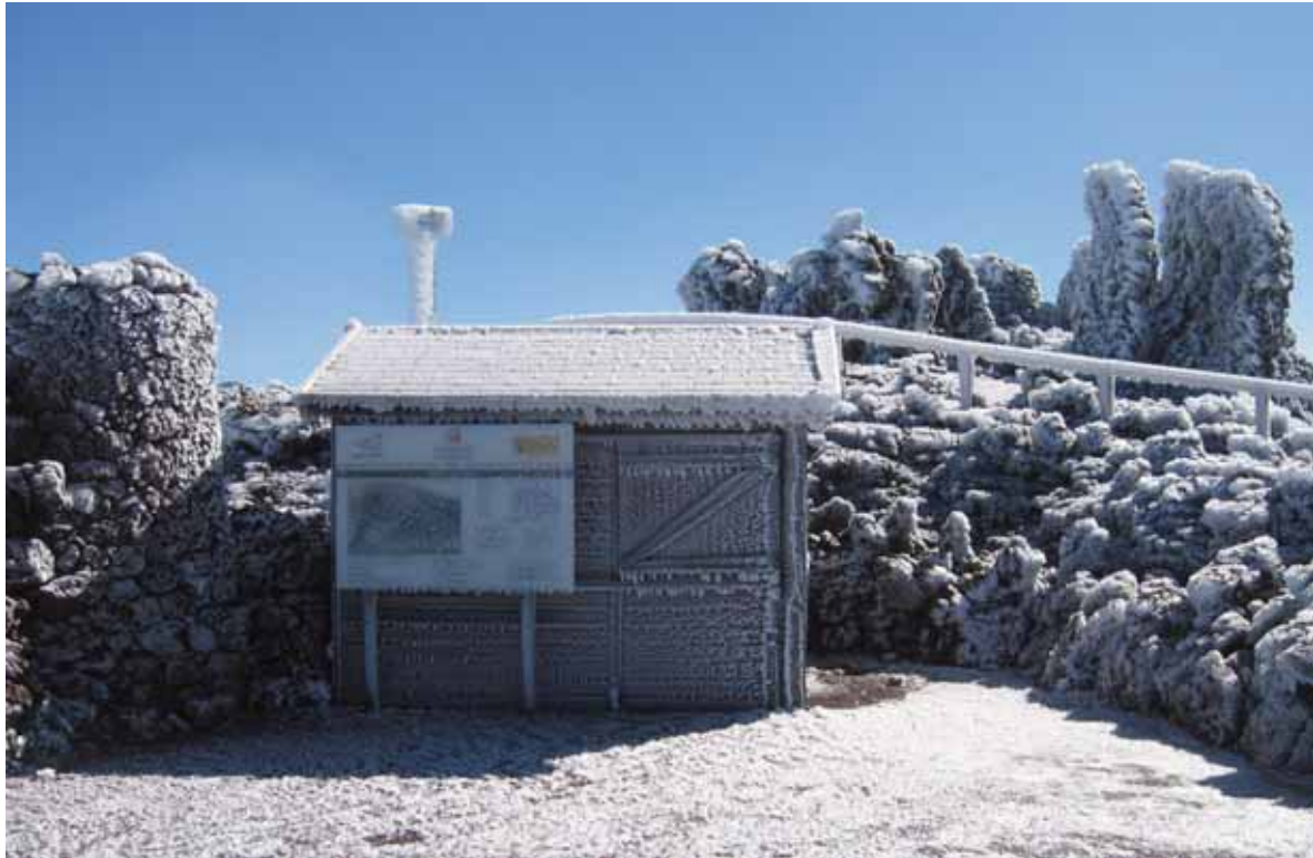
Roque de los Muchachos y caseta de información con cencellada.
