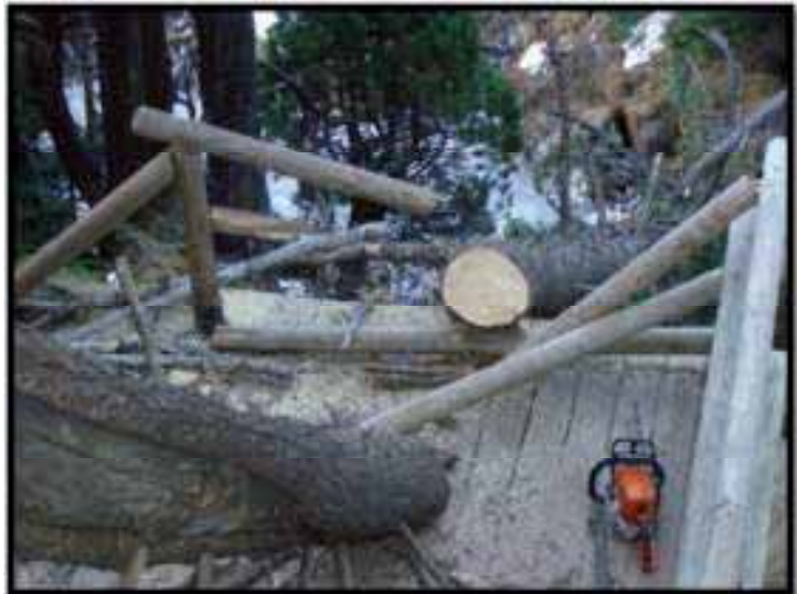
Foto 13: Reparació desperfectes Mirador cascada de Gerber
