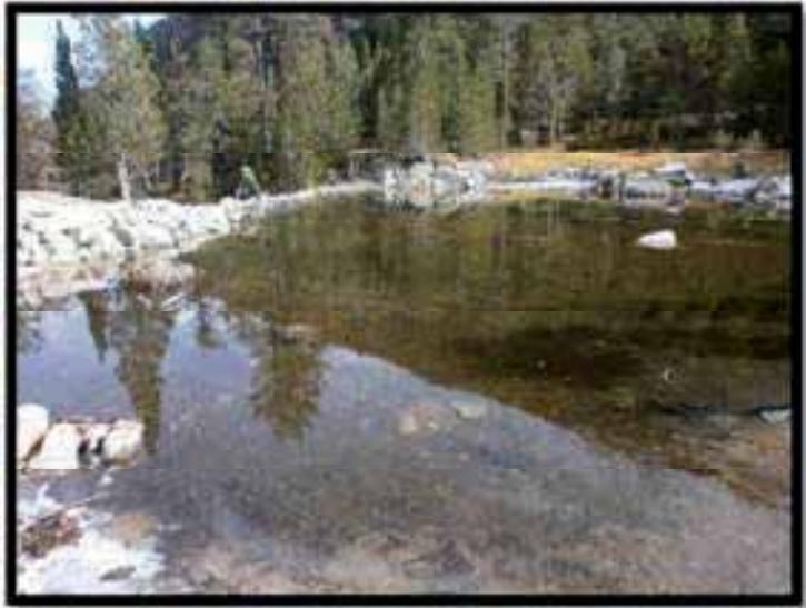
Foto 17: Desmantellament presa de la Font Grossa
