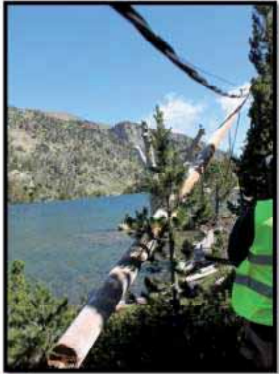
Foto 15: Desmantellament línia elèctrica de Peguera
