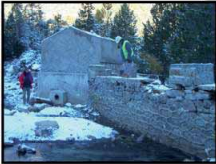
Foto 16: Desmantellament presa de la Font Grossa
