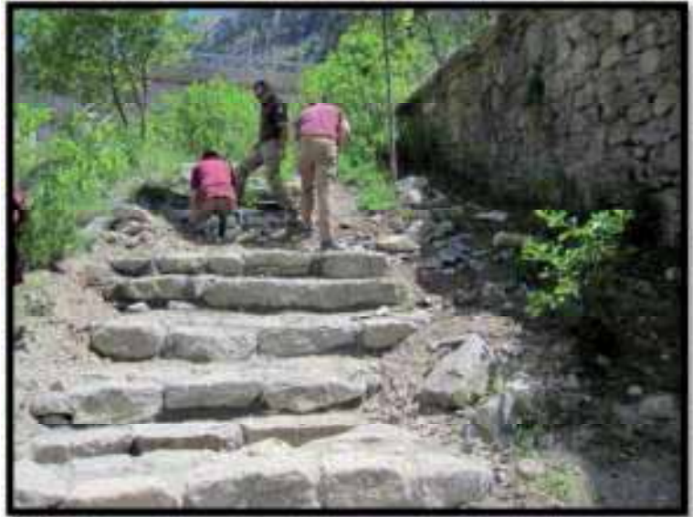
Foto 38: Construcció d'esgraons camí de Cavallers
