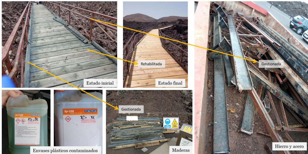
Detalles de los residuos de la obra
