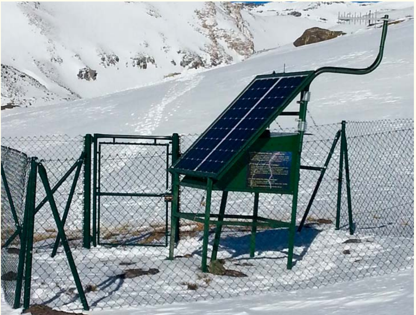
Vista de la estación de seguimiento.
