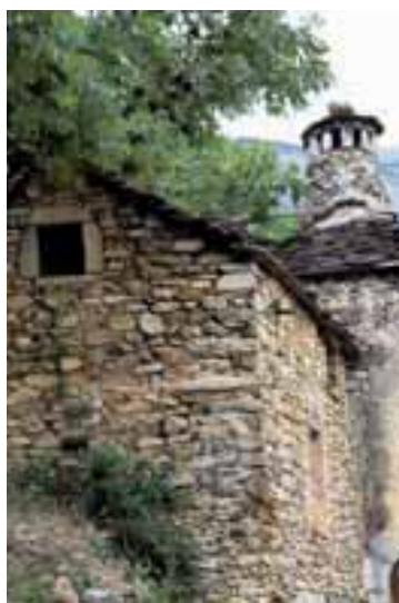
Casa y chimenea en Escuaín
