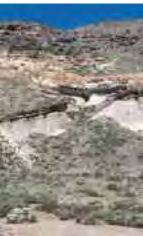
Falla de asentamiento en la pared de Diego Hernández.
