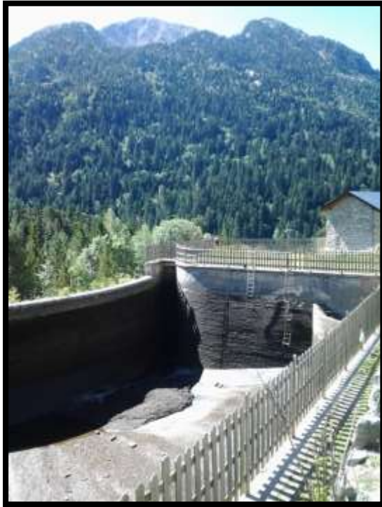
Foto 18: Buidatge de la presa de Sant Esperit
