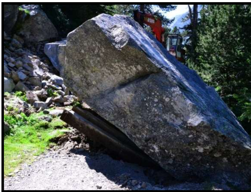
Foto 20: Retirada del bloc caigut a la vora de la pista d'accés a l'Estany Llong
