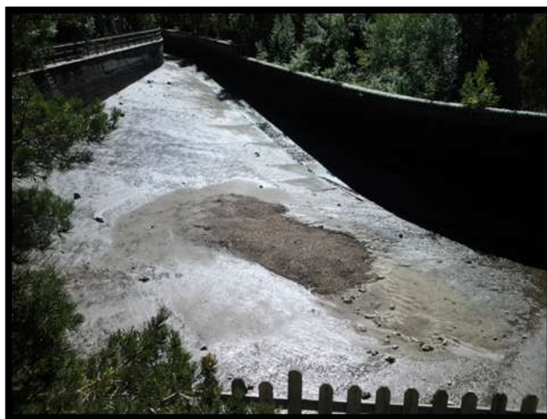
Foto 17: Buidatge de la presa de Sant Esperit
