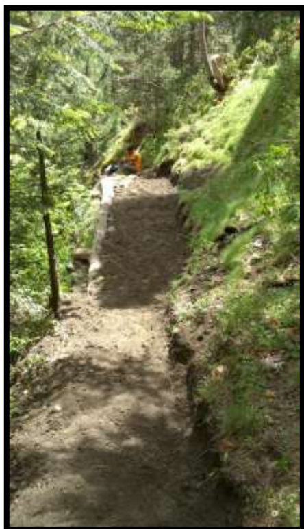
Foto 46: Treballs de consolidació al camí de la Montanyeta
