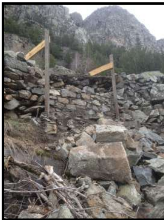
Foto 42: Reparació mur carretera Aigüestortes
