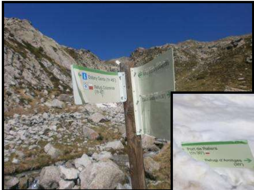
Foto 79: Señales dañadas por la nieve
