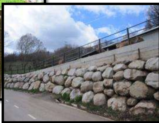
Foto 81: Mejoras en muros de granja
