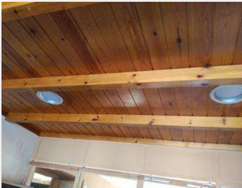
Foto 88: Nueva iluminación tipo led
