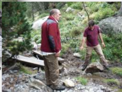
Foto 64: Mejora de un tramo de camino de acceso a Colomers
