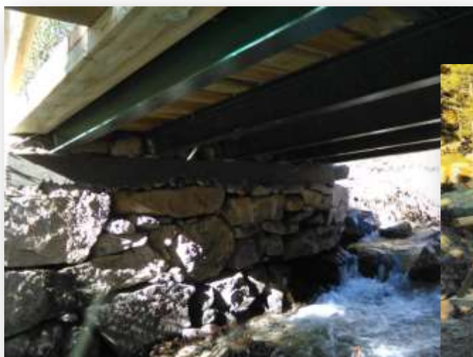
Foto 61: Renovación del puente sobre el río Ratera en la pista forestal de Amitges
