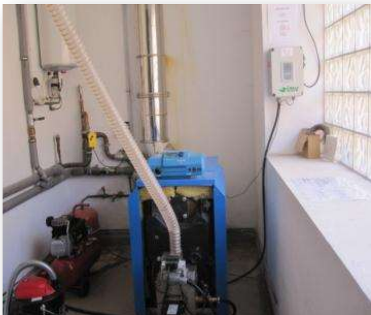
Foto 89: Instalación quemador de pellets en el centro de Senet
