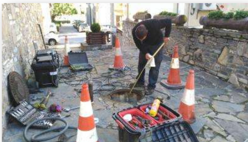
Foto 57: Inspección depósito de gasóleo de la Casa del Parque de Espot
