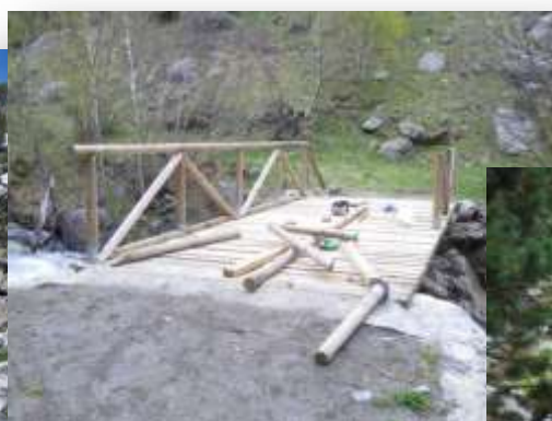
Foto 62: Reconstrucción del Pont de Arena
