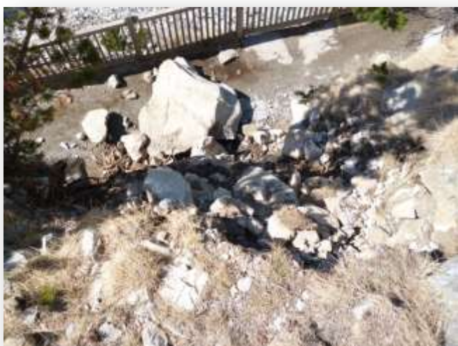
Foto 27: Piedras caídas en el camino de la presa de Cavallers
