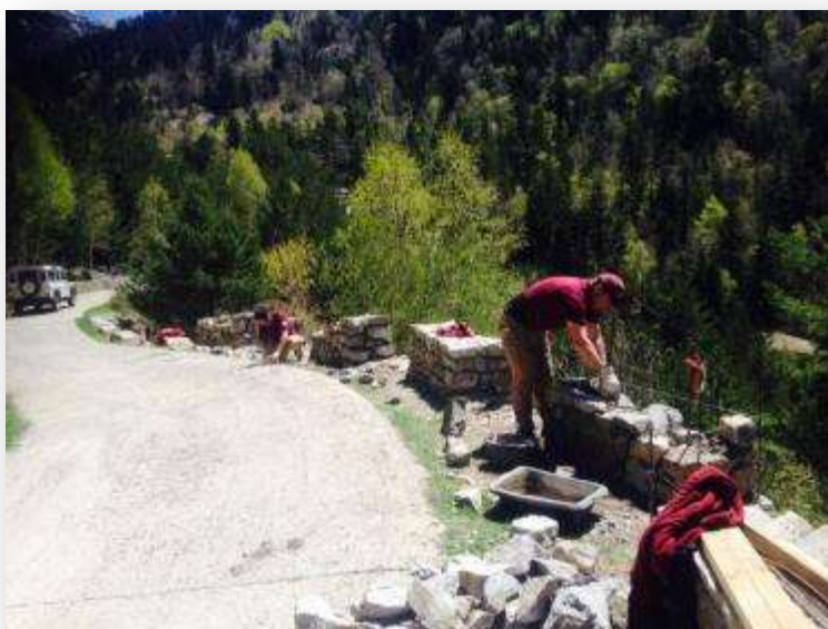
Foto 60: Construcción de muros en la carretera de Aigüestortes
