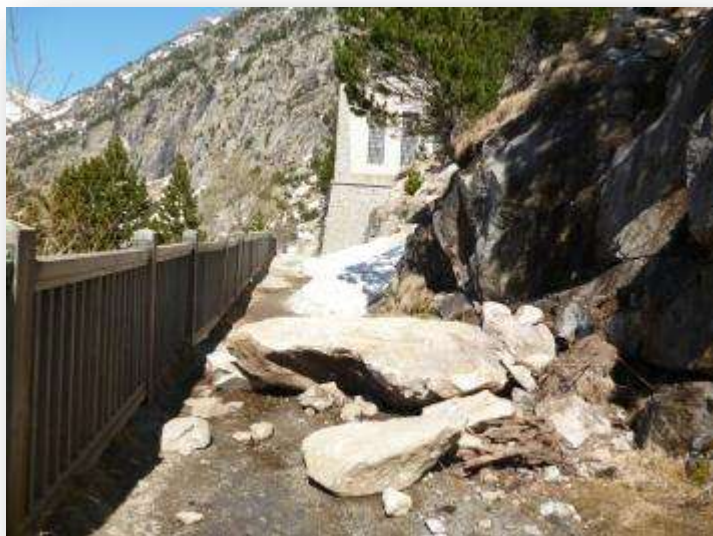
Foto 58: Desprendimiento de Cavallers
