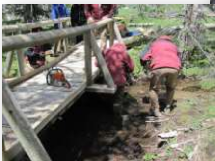
Foto 67: Reparación pasarela de Aigüestortes
