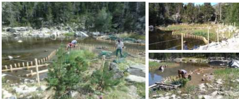
Imagen 11: Trabajos de instalación del cercado ganadero y trasplante de Carex en la Turbera de la Font Grossa. Fuente: archivo fotográfico.
