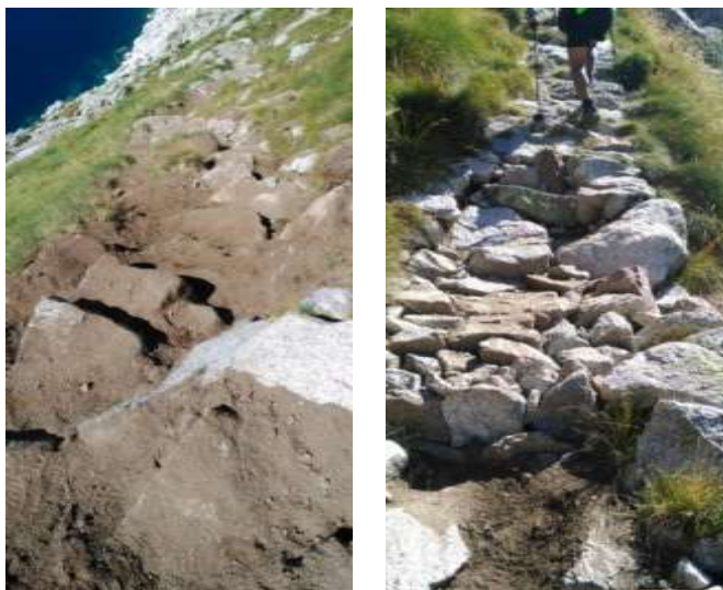
Imagen 28: Construcción de un empedrado en el camino de Pigolo (Sector Vall Fosca) Fuente: Archivo fotográfico
