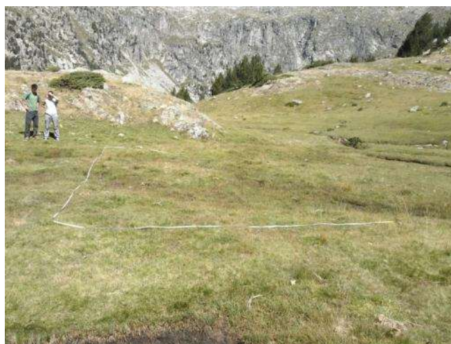
Imagen 8: Trabajos de instalación del cercado ganadero en el Pletiu de Erdo. Fuente: archivo fotografico.
