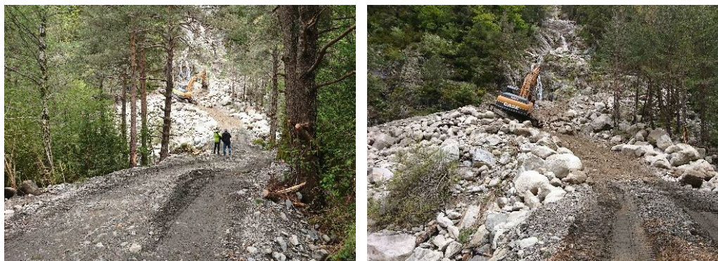
Imatge 18 i 19 Actuacions de restauració de la llera del riu Sant Nicolau amb la confluència amb la canal del Caldo. Font: arxiu fotogràfic del Parc
