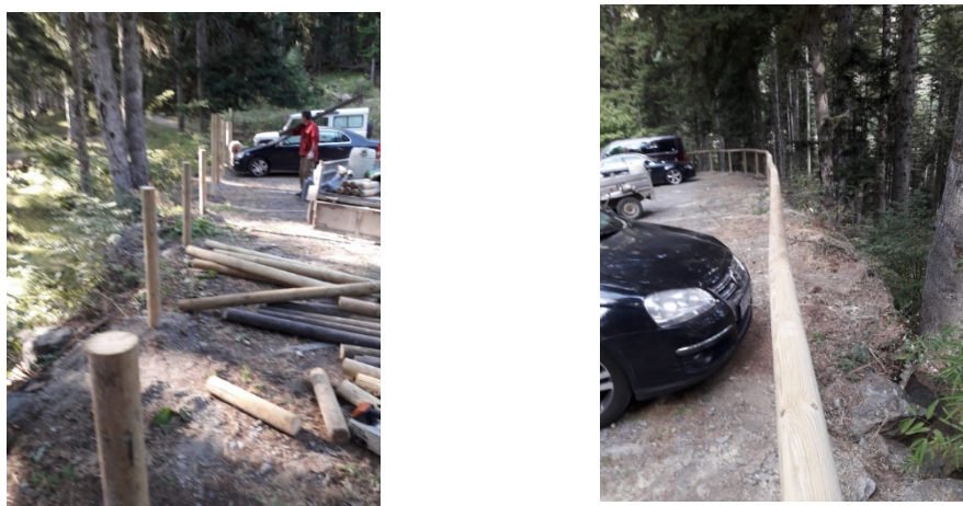
Imatge 27 i 28 Substitució de la fusta de la barana de l'aparcament del Gerdar. Font: arxiu fotogràfic del Parc
