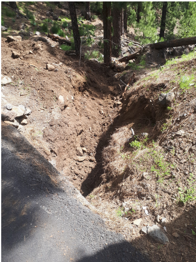
Retirada de sedimentos en desagüe de la carretera de acceso a La Cumbrecita
