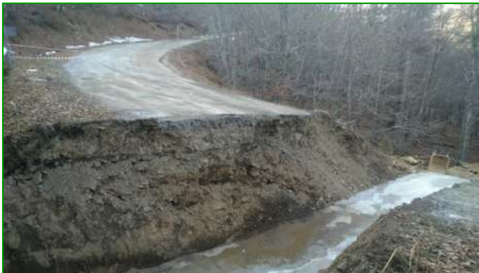
Fotografía 1. Camino cortado por escorrentía en el Parque Nacional de los Picos de Europa (Fecha 30/12/2019)
