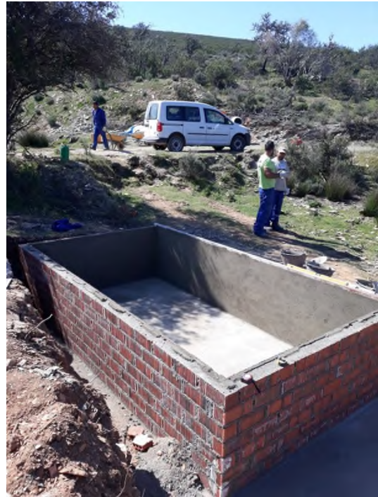
Desarrollo de la construcción: muro de un pie de ladrillo macizo
