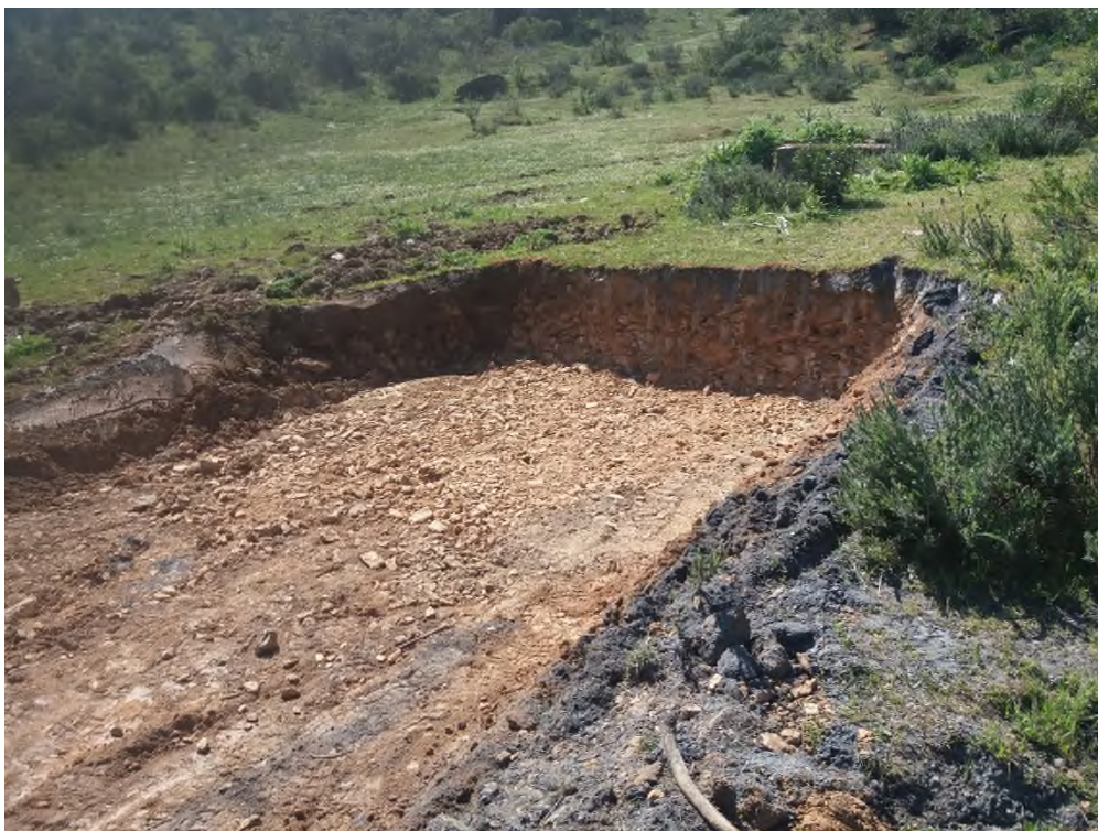
Cajeado para cimentación
