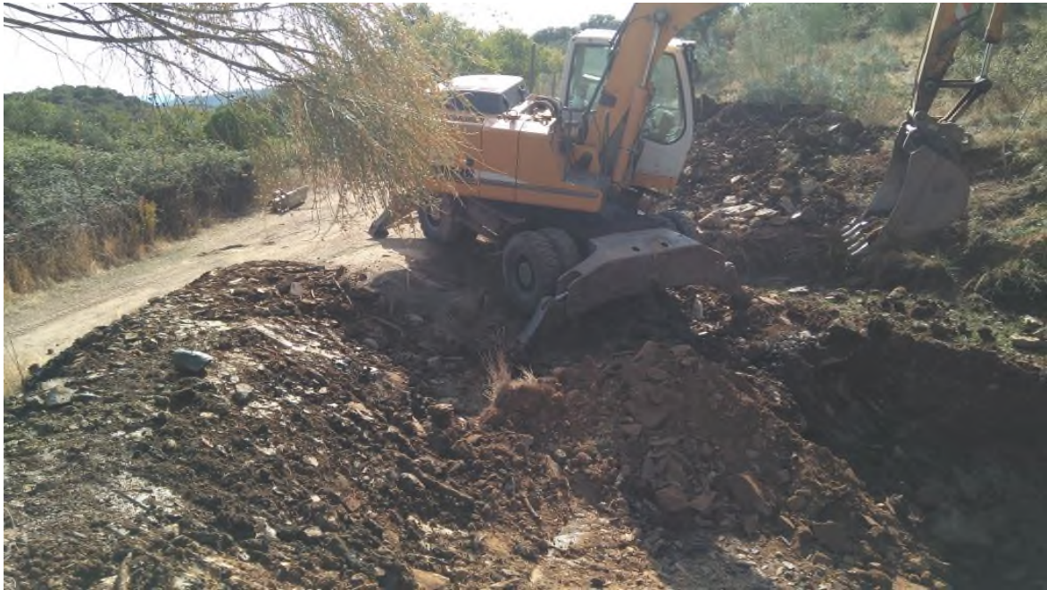
Trabajos de modulación de orillas
