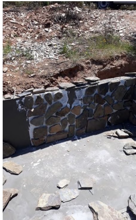
Desarrollo de la construcción: impermeabilizado y revestimiento con chapado de piedra de pizarra
