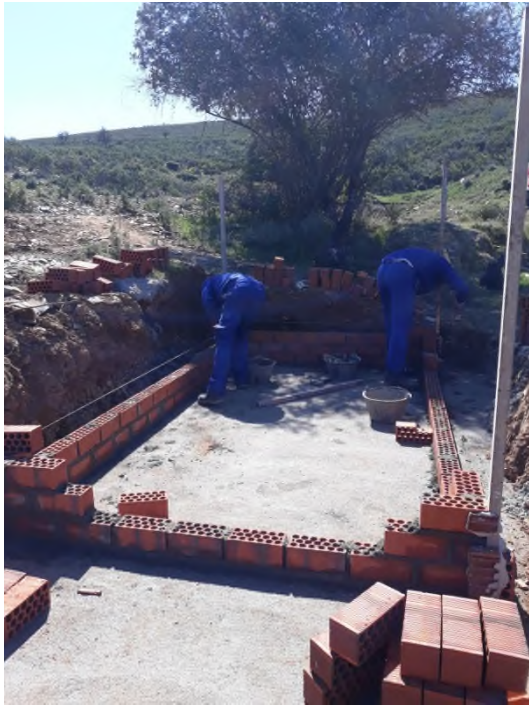
Desarrollo de la construcción: muro de un pie de ladrillo macizo
