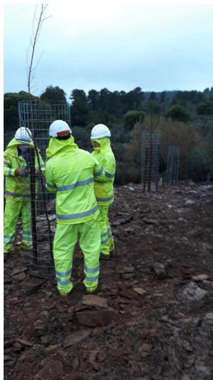
Colocación de jaula protectora
