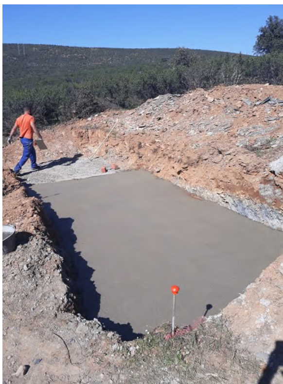
Solera de hormigón
