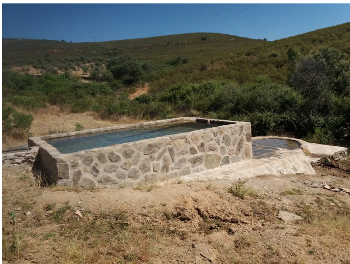
Detalle final de la fuente con balsa auxiliar
