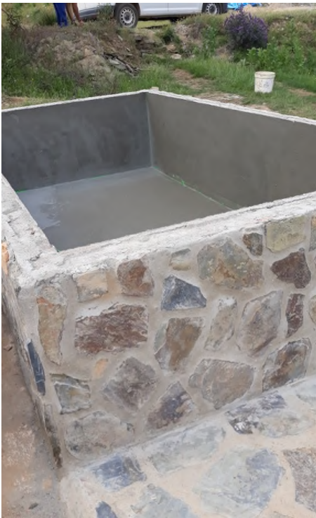
Desarrollo de la construcción: impermeabilizado y revestimiento con chapado de piedra de pizarra
