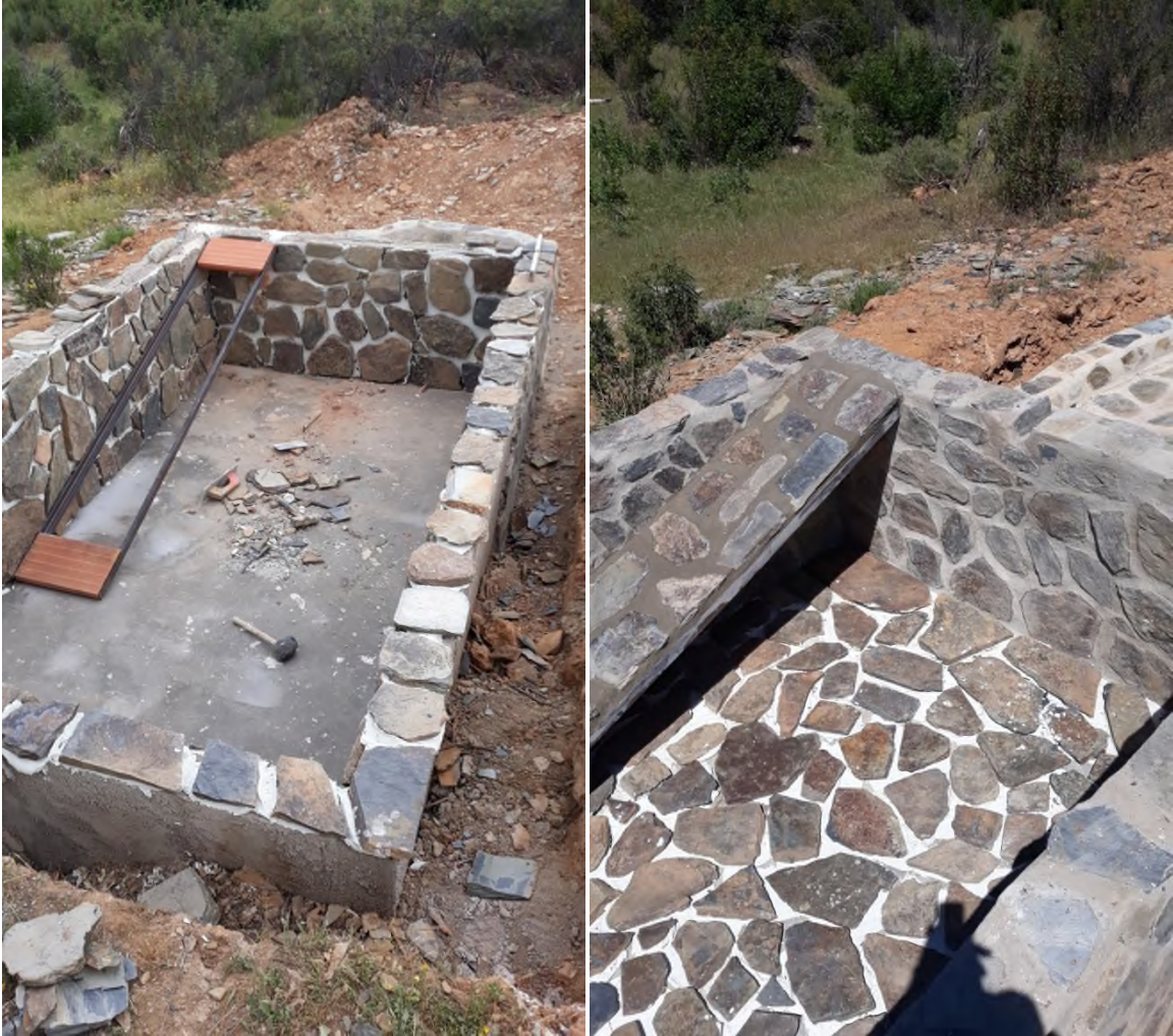
Desarrollo de la construcción: rampa
