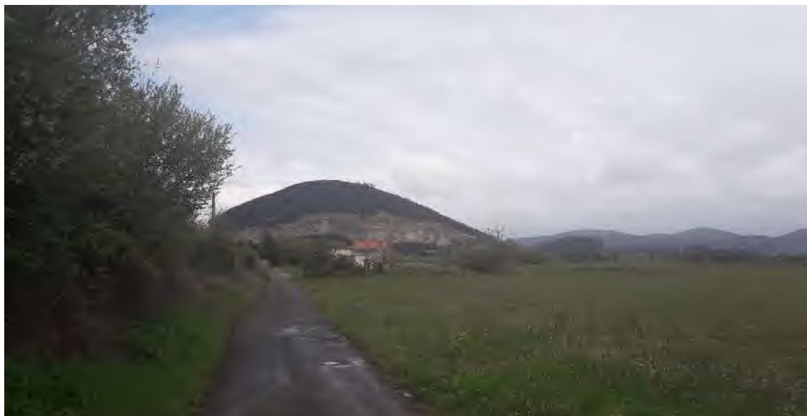
Foto 1: LAT 12/20 kV Treto-Santoña dentro de la zona de Dominio Público-Marítimo Terrestre.
