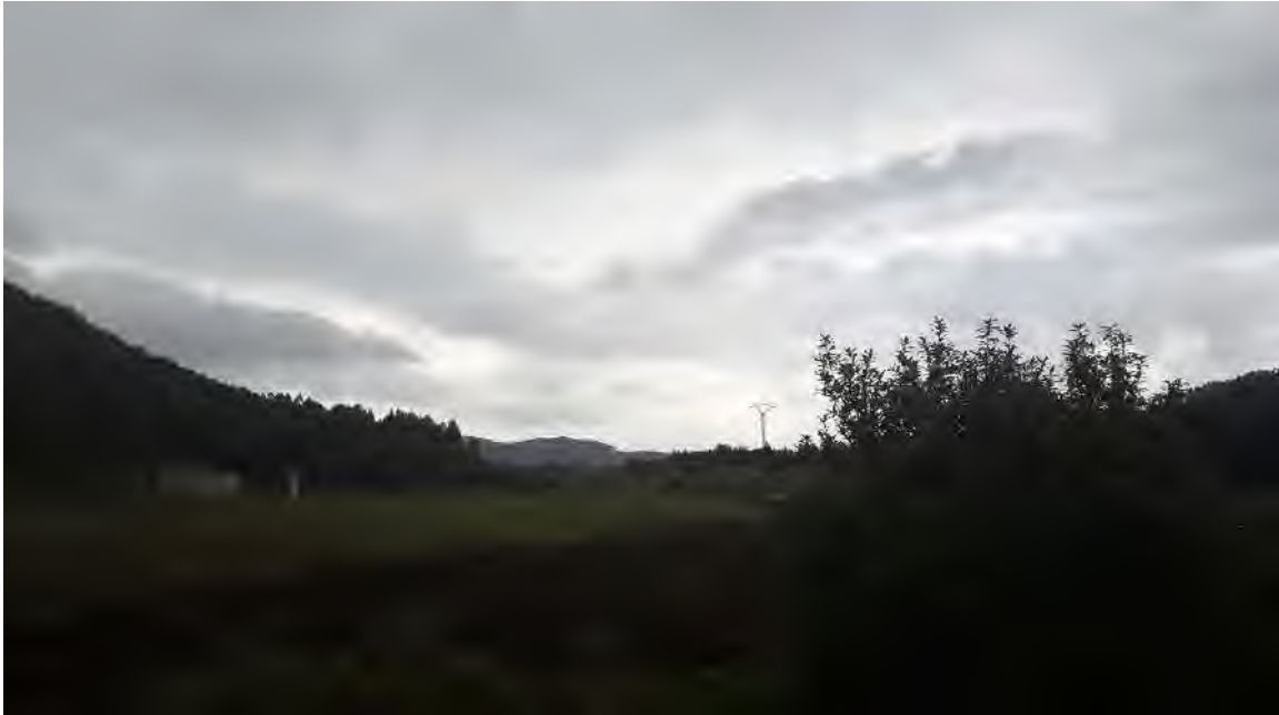
Foto 5: LAT 12/20 kV Treto-Santoña y CTC Rivero dentro de la zona de Dominio Público-Marítimo Terrestre.
