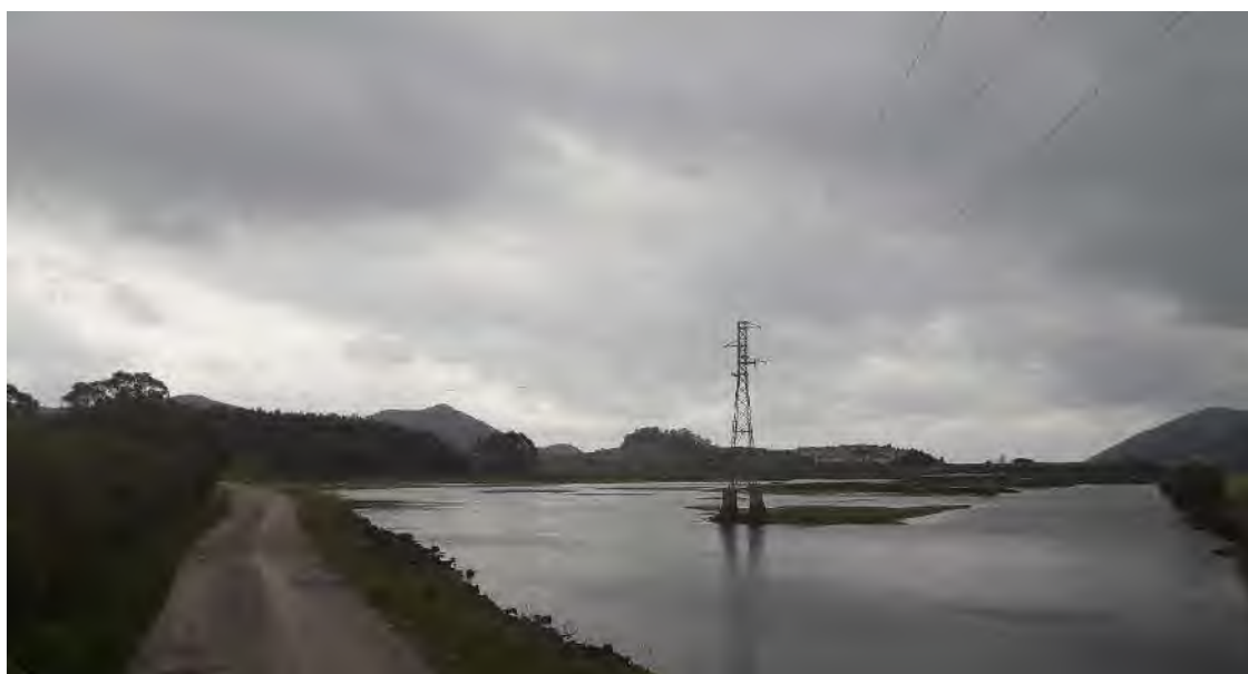
Foto 4: LAT 12/20 kV Treto-Santoña dentro de la zona de Dominio Público-Marítimo Terrestre.
