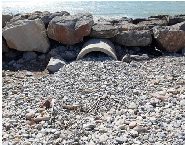
FOTO 2. Estado actual a fecha de la firma del proyecto básico (lado de la playa) de la salida natural histórica hacia el mar del agua de escorrentía superficial. La dejadez y falta de mantenimiento ha embozado esta salida natural histórica.
