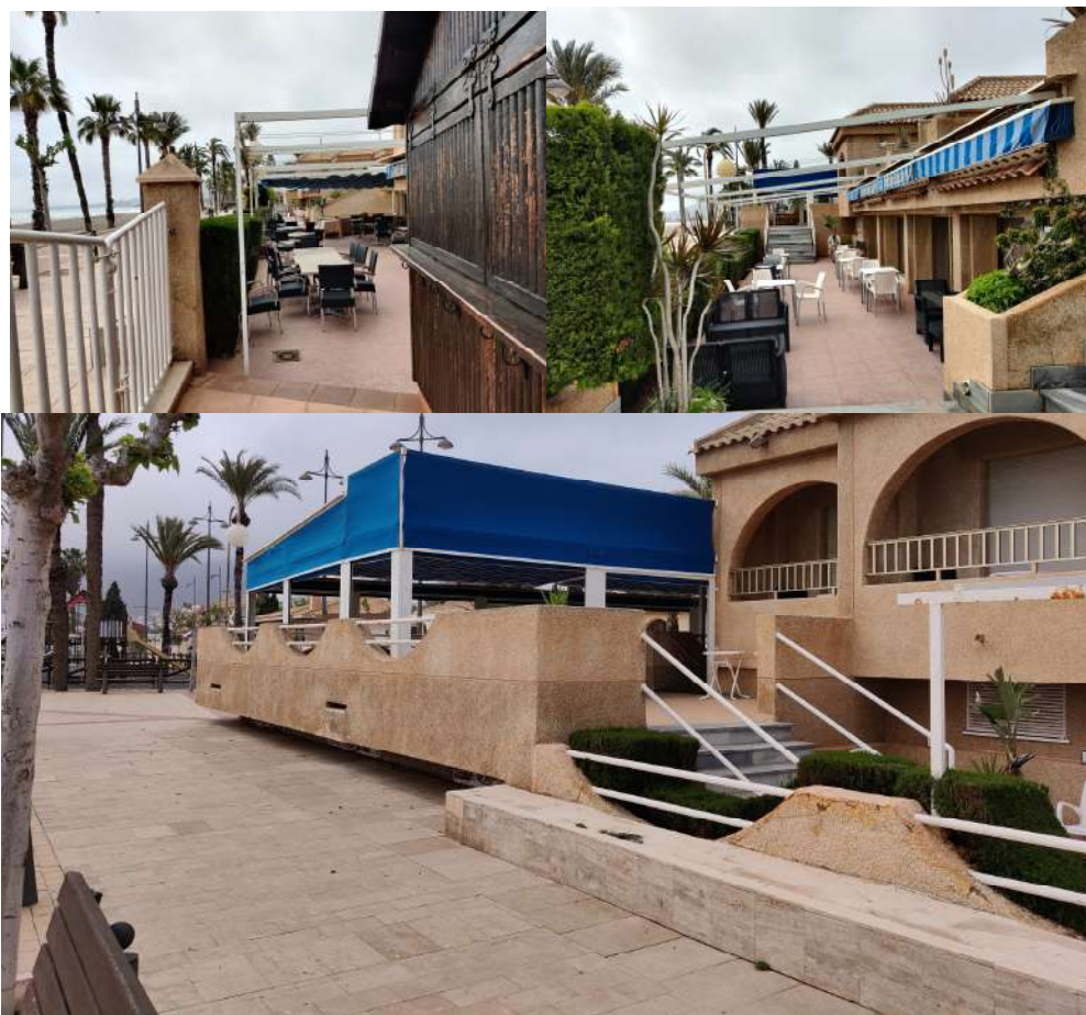
Figura 14. Detalle ocupación parcela de deslinde nº 39. Terrazas y porche de restaurante (La Mesquera)
