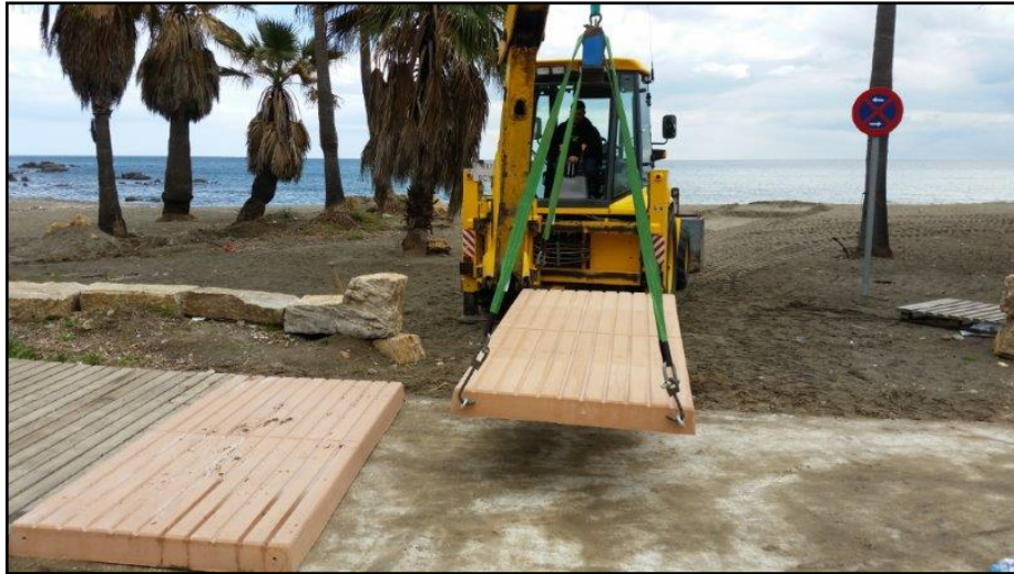
Ilustración 5. Montaje de los módulos de hormigón prefabricado.
