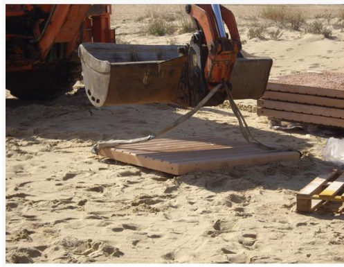
Ilustración 2. Montaje de placas de hormigón prefabricado.
