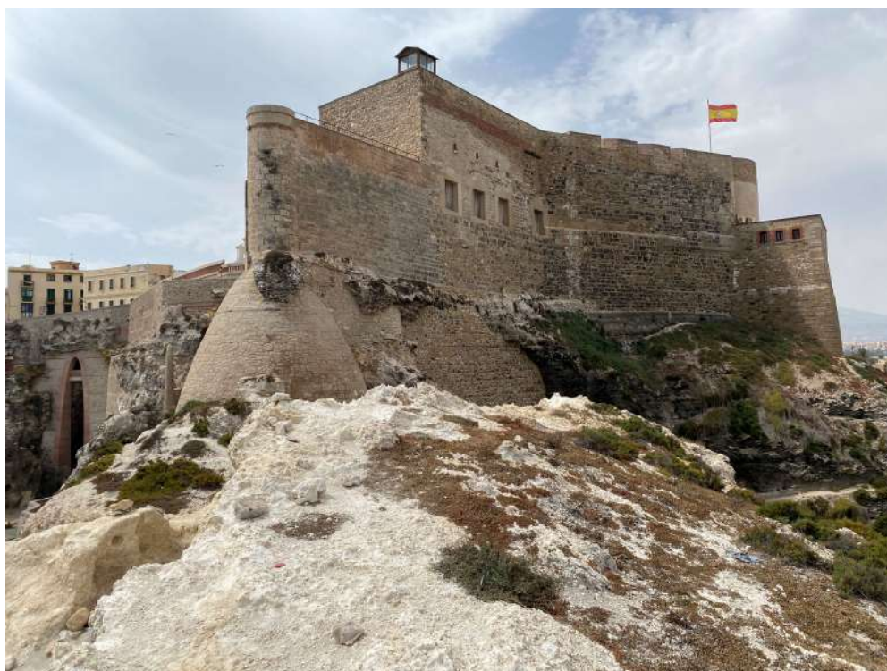
Penúltimo tramo, lugar donde se ubicará el mirador. Al fondo, vista de la cala de Trápana
