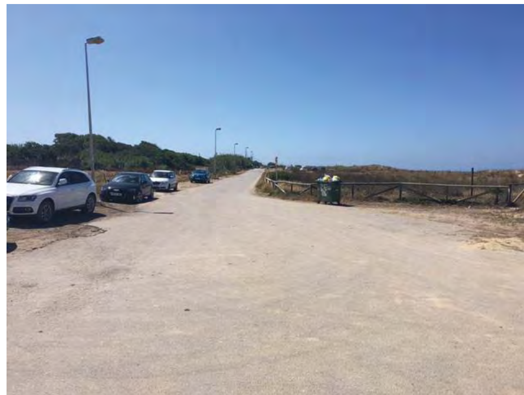
Figura 2. Camino de asfalto ubicado en la margen derecha del arroyo Conilete, mirando hacia el Palmar
