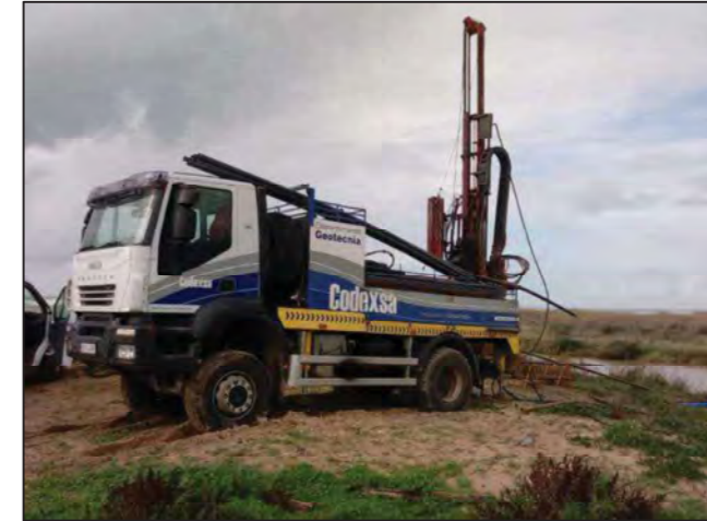
Detalles de la ejecución del sondeo
