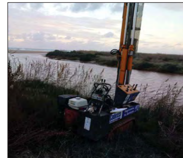
Detalle de la realización de los ensayos penetrométricos
