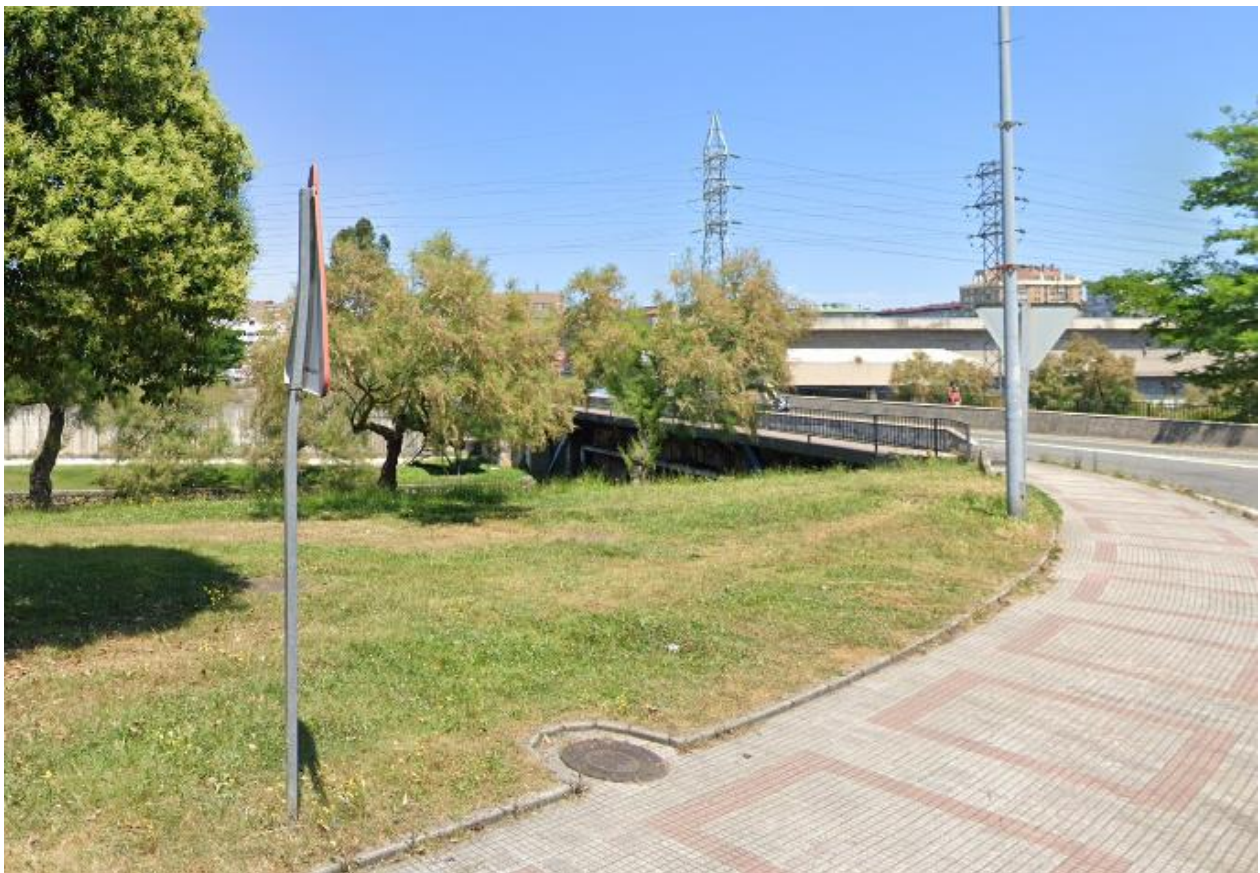
Ilustración 37. Detalle de la zona adyacente al puente donde se ubican las dos tapas de registro
