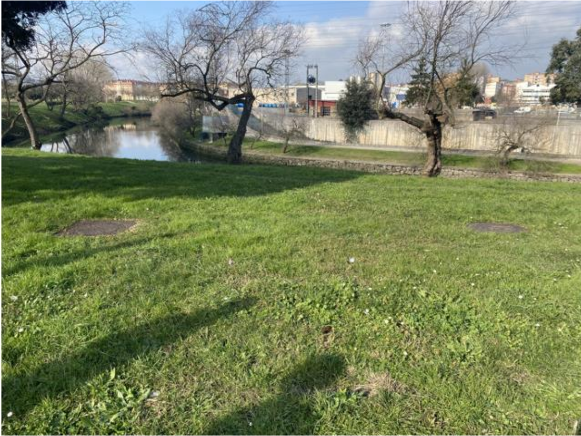
Ilustración 34. Detalle de la zona adyacente al puente donde se ubican las dos tapas de registro
