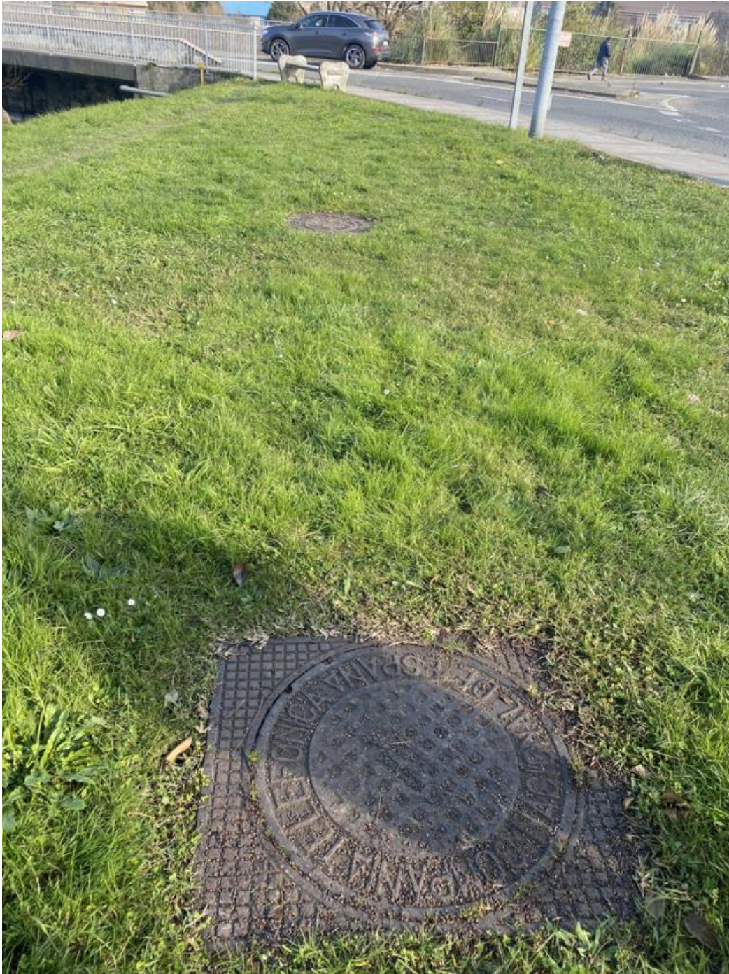
Ilustración 33. Detalle de la zona adyacente al puente donde se ubican las dos tapas de registro
