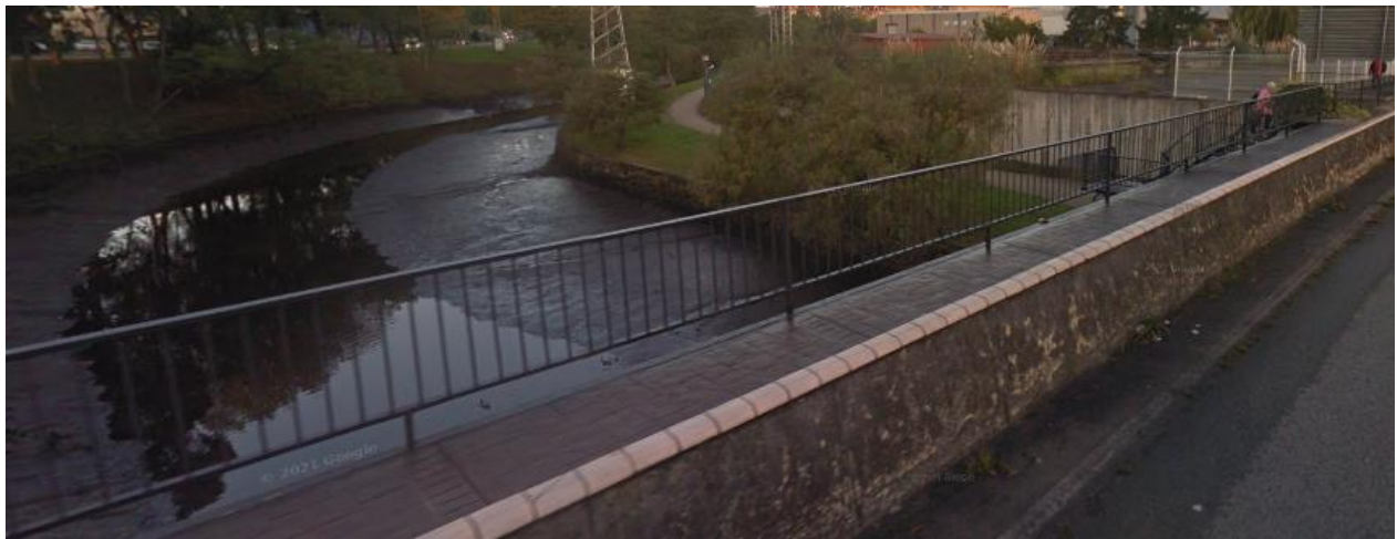
Ilustración 25. Aspecto actual del puente de la Avenida Bilbao (Astillero y Camargo)
