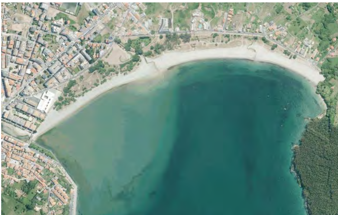
Imagen 19: Ortofoto de la situación actual, equivalente a la Alternativa 0: No actuación. Fuente: IGN.
