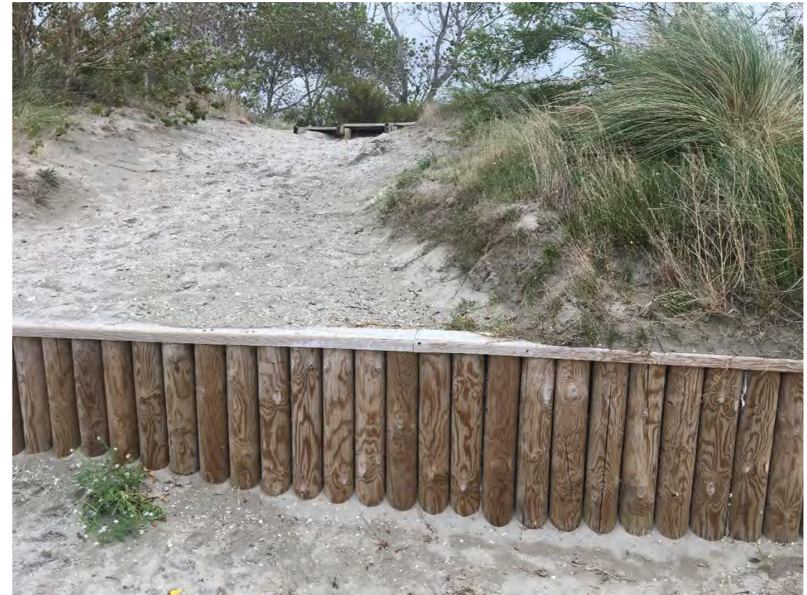
Imagen 16. Empalizada de madera (4). Fuente: Elaboración propia.
