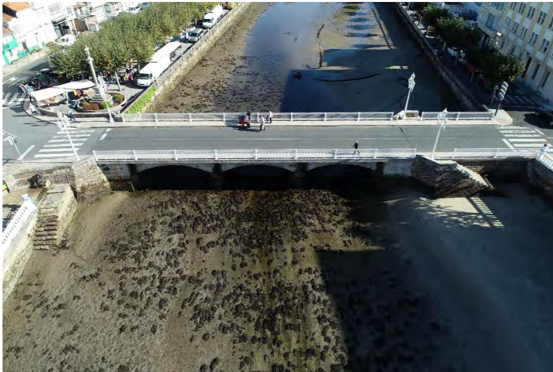
Imagen 8: Desembocadura Ríu Condomiñas. Fuente: Elaboración propia.
