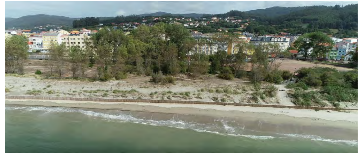
Imagen 14: Empalizada de madera (2). Fuente: Elaboración propia.
