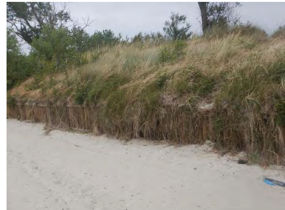
Fotografía 7. Detalle de los rollizos de madera en el primer frente dunar
