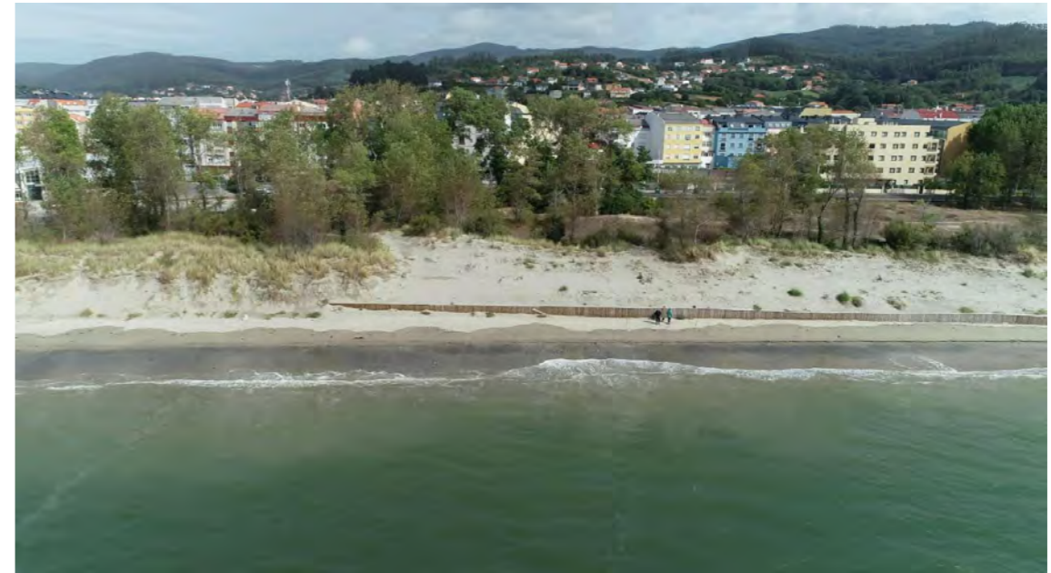
Imagen 13: Empalizada de madera (1). Fuente: Elaboración propia.
