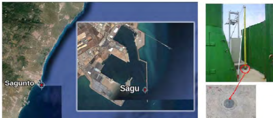
Imagen 4 : Posición del mareógrafo en el Puerto de Sagunto (izda.) y fotografía de la Estación con detalle del clavo metálico incrustado en el cantil del muelle de Levante (dcha.). Fuente: REDMAR.
