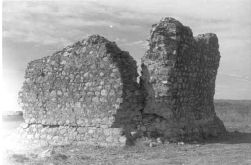
Fig. 3: Estado de la torre de Biesma en 1979
