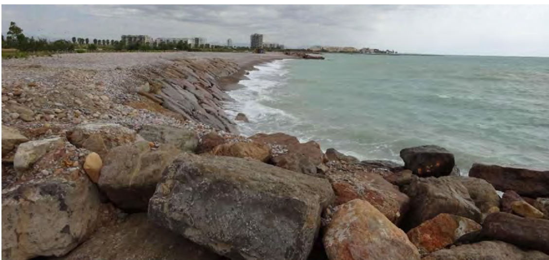
Fotografía 26. Escollera de protección - calle playa Camino Cabrés [3]
