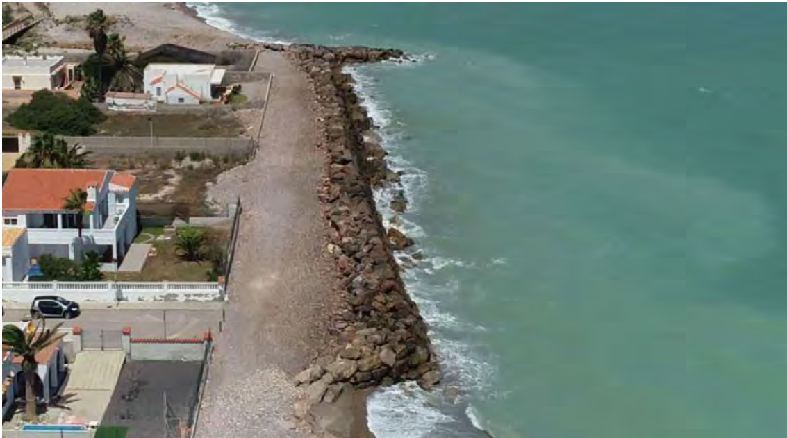
Fotografía 25. Escollera de protección - calle playa Camino Cabrés [2]
