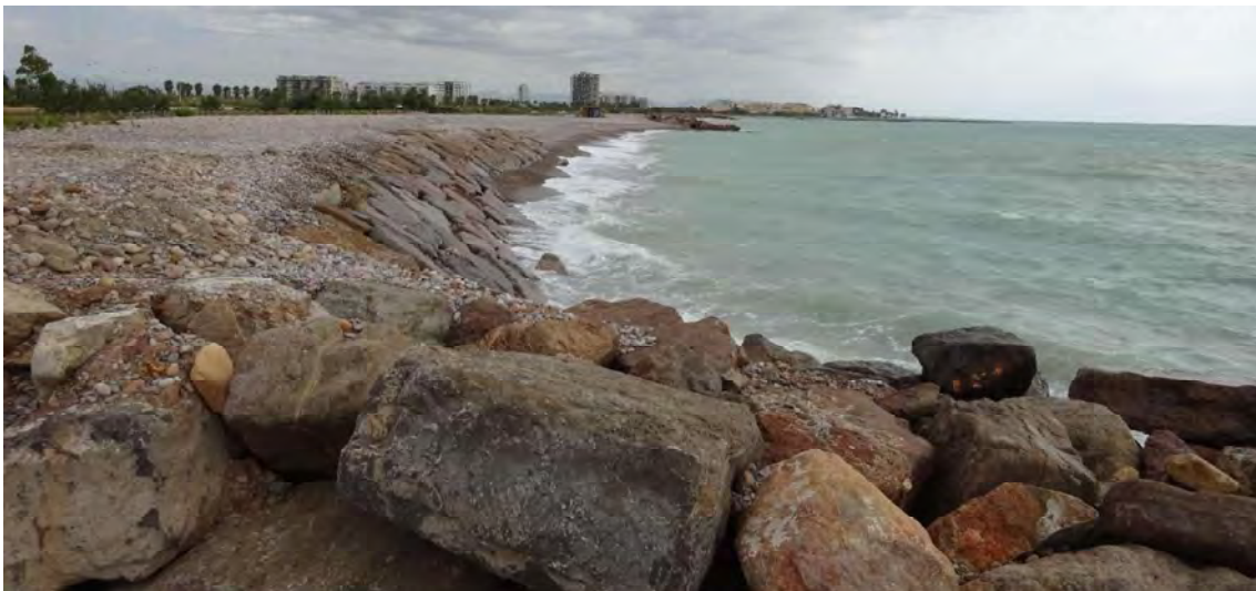
Fotografía 26. Escollera de protección - calle playa Camino Cabrés [3]
