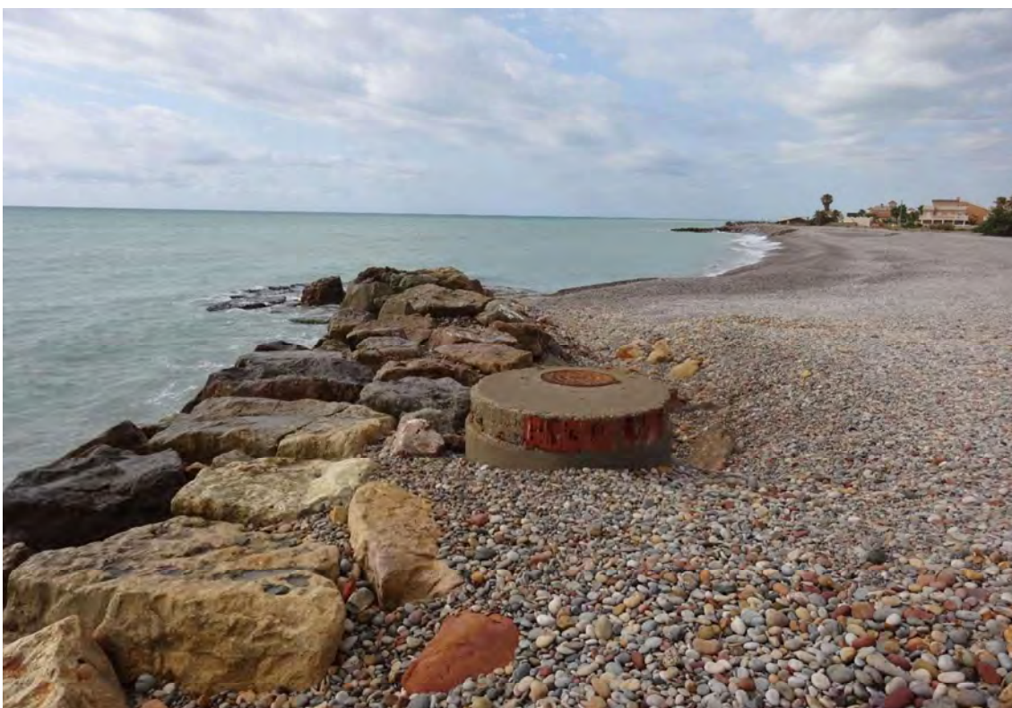
Fotografía 33. Detalle de la playa de la Torre [2]
