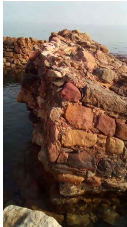
Figs. 10, 11 y 12: Detalle de los muros conservados de mampostería de cal, cantos y sillares.
