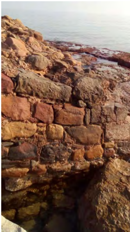
Figs. 10, 11 y 12: Detalle de los muros conservados de mampostería de cal, cantos y sillares.
