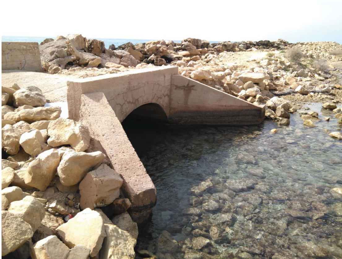
Obra de fábrica existente
