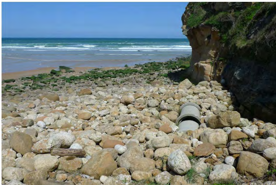
Tramo final con tubería de hormigón (HA de 1000)
