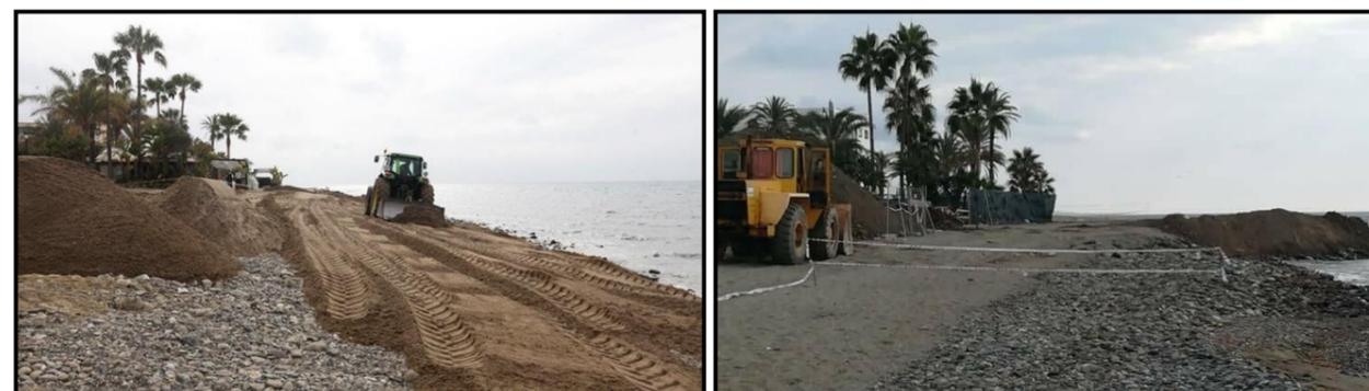
Figura 3. Fotografías de aportación de arenas en el entorno del río Guadaiza “tapando” bolos de la playa natural.
